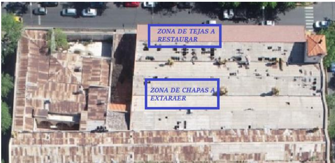
Figura 27 Vista aérea de zona de trabajo
