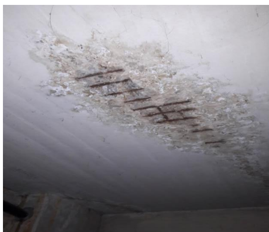
Figura 39 Vista de armaduras en losas
