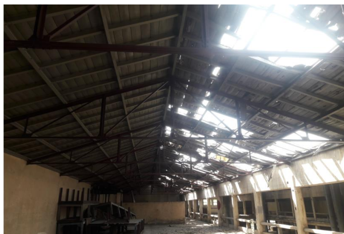
Figura 6 cubierta de techo
