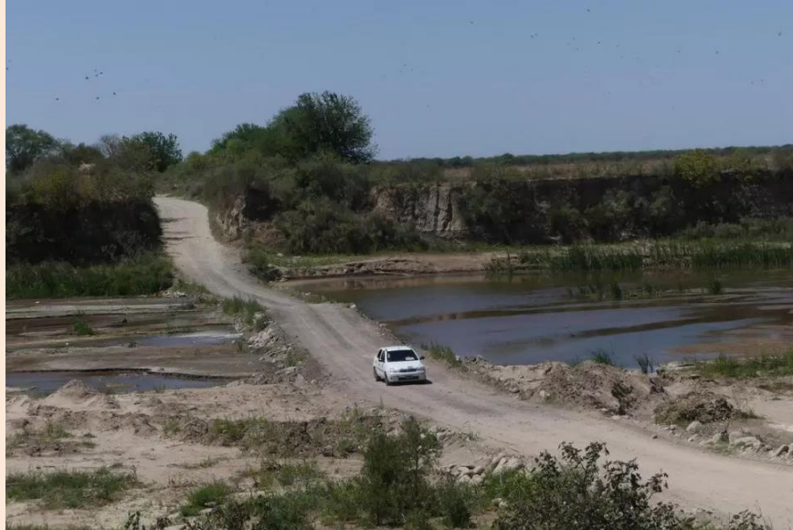
Figura 5. Cruce actual de Río San Francisco sobre Ruta Provincial n°334, formado por un badén de suelo y caños metálicos y de hormigón permitiendo el paso del cauce.
