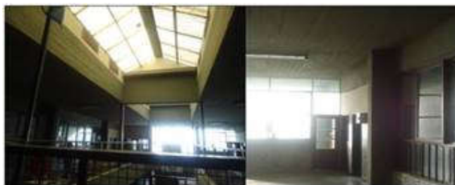
Figura 4: Vista del patio central del 1er piso (izq.) y Vista de la losa en el pasillo principal (der.).
