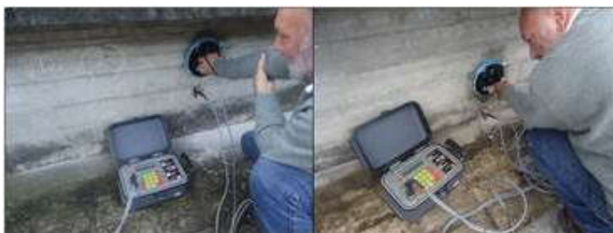
Figura 10: Medición de corrosión con GECOR 6 (izq.) y Medición de corrosión con GECOR 6 (der.)
