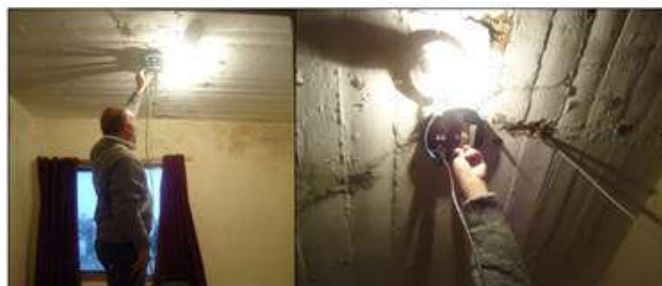
Figura 6: Medición de corrosión con GECOR 6 (izq.) y Medición con GECOR 6 en losa sobre 2 do piso (der.).
