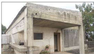
Figura 5: Vista de la losa sobre 2do piso, vista desde la terraza.
