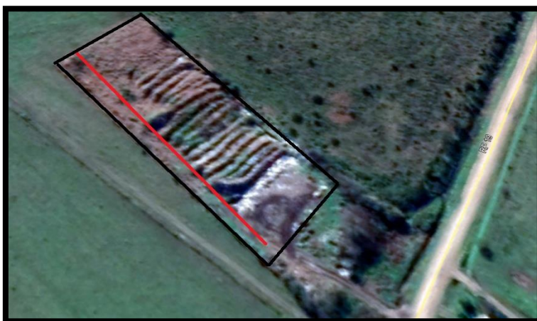
Figura 29: Vista satelital del vertedero. Corte de sur a norte marcado por recta roja. Fuente: Google Maps (08/02/2017).
