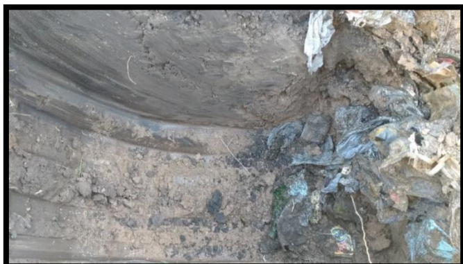
Figura 25: Foto pozo de cateo 2. Fuente: Propia.
