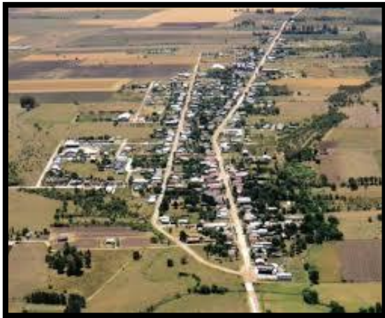
Figura 8: Foto área de Aldea San Antonio. Fuente: Google
