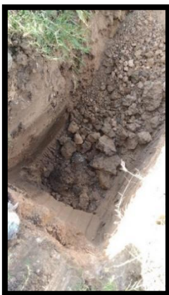
Figura 24: Foto pozo de cateo 1. Fuente: Propia.
