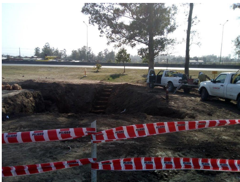
Foto 2: Sector de obra de empalme de gasoducto
