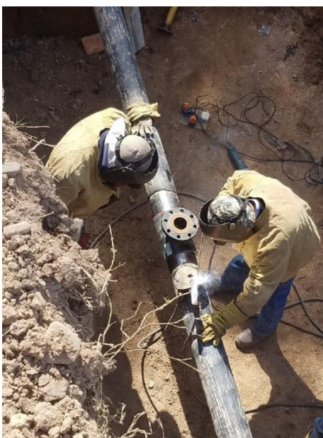
Foto 4. Posición de trabajo del soldador en momento de empalme.
