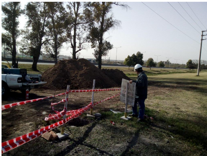
Foto 1: Sector de obra de empalme de gasoducto
