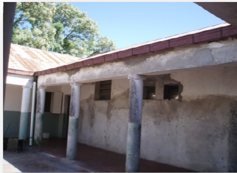
Figura N° 4.1.1.12 Foto Galería Pabellón Femenino
