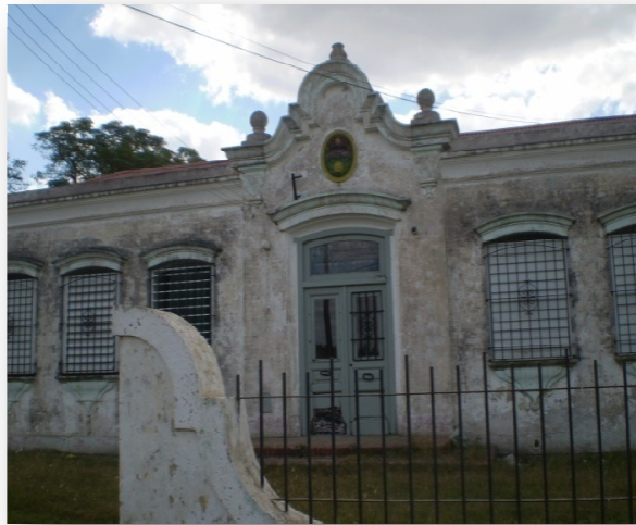
Figura N° 4.1.1.4 Foto Vista Sur. Hospital Liniers
