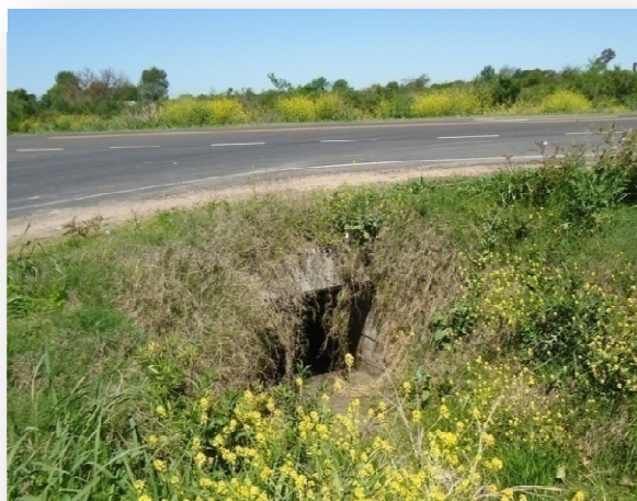
Figura N° 7.3.2.2.2 Alcantarilla N°2 Existente
