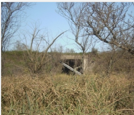
Figura N° 7.3.2.2.1 Alcantarilla N°1 Existente
