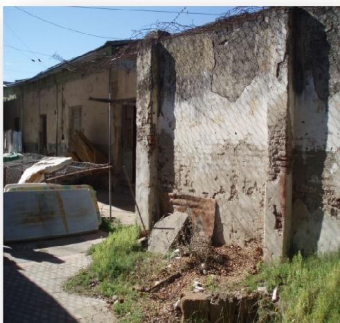
Figura N° 4.1.1.7 Foto 2 Galería Ala Sur
