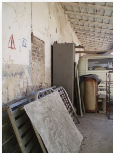
Figura N° 4.1.1.6 Foto 1 Galería Ala Sur
