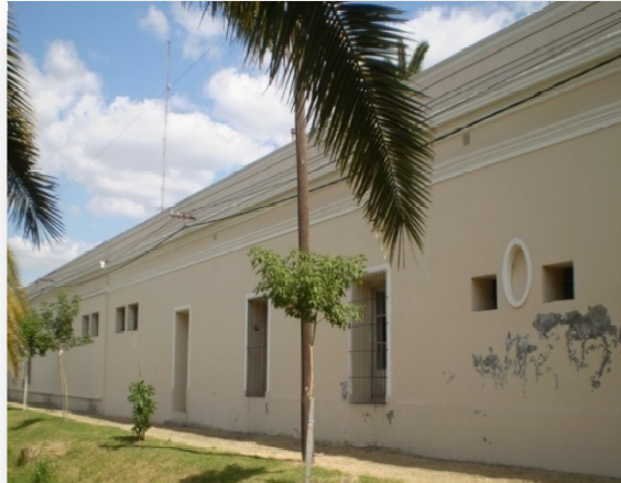
Figura N° 4.1.1.2 Foto Vista Este. Fachada Hospital Liniers
