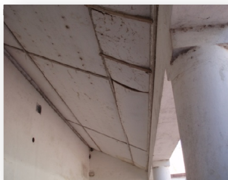
Figura N° 4.1.1.13 Foto Cielorraso de Galería Pabellón Femenino
