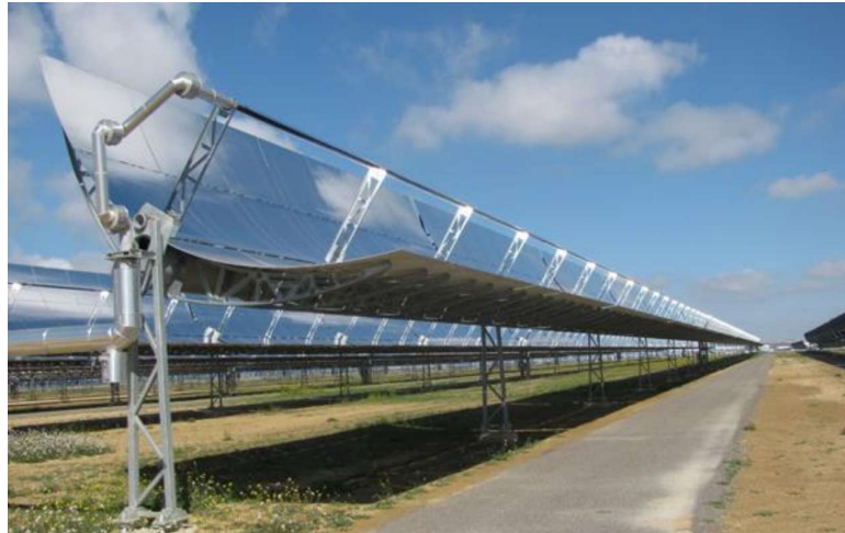
Figura 9-25: Campo de concentradores cilíndricos parabólicos. Referencia [74].
