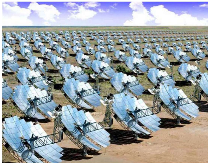
Figura 9-40: The Stirling Energy Systems (SES) California, EE.UU. Referencia [85].
