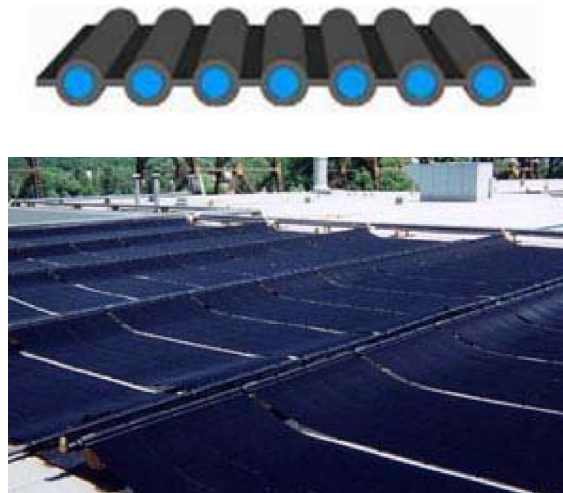
Figura 5-7: Colectores de placa plana sin cubierta, de caucho polimérico. Referencia [34].
