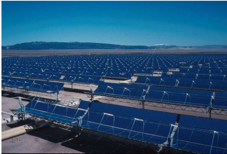
Figura 9-26: Central de 354 MW en “Northern San Bernardino County”, California. Referencia [75].
