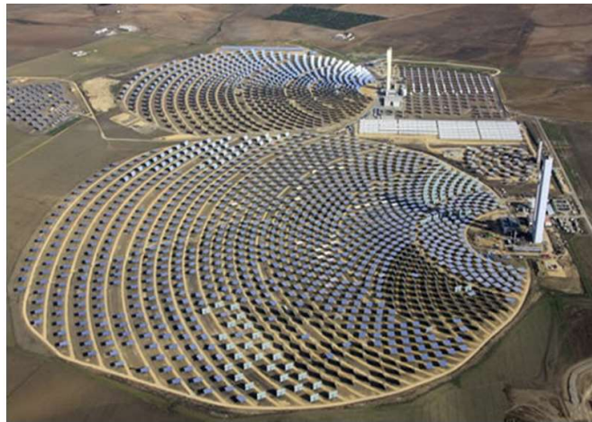
Figura 9-33: Emprendimiento de Torre Central en Sevilla, España. PS10 (10 MW) y PS20 (20MW). Referencia [79].
