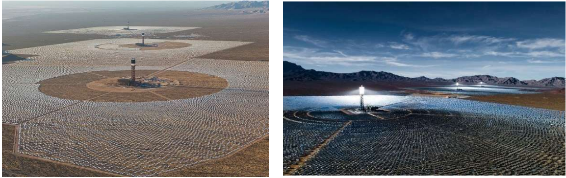
Figura 9-34: Sistema Solar Ivanpah. Desierto de Mojave, EE.UU. 390 MW. Formada por 3 módulos de 130 MW. Cada módulo tiene 100.000 espejos. Área total 13 km 2 . Referencia [80].
