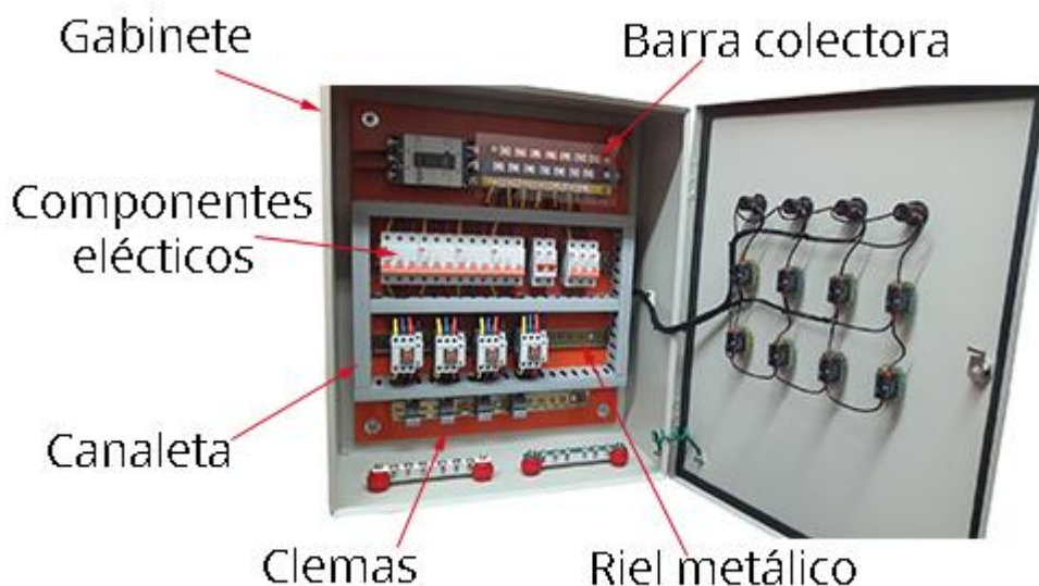
Fig. 13-3 Constituyentes eléctricos de un tablero. Fuente: Mecafenix.
