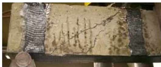
Viga corroída y reparada
