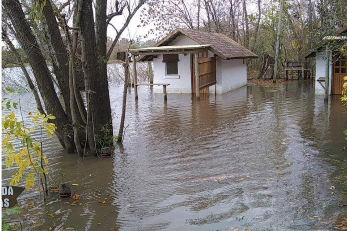
Figura 14. Afectación de las crecidas en el complejo turístico Punta Sur en el año 2019.
