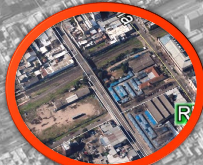
3 PUENTE 14 DE AGOSTO
