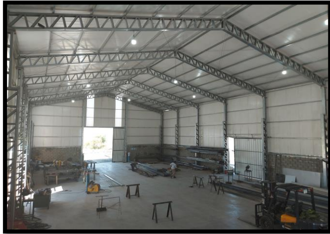
Figura N°6: Interior del galpón.
