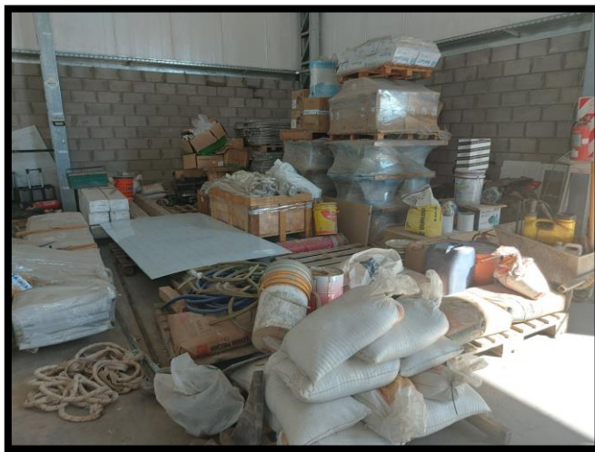
Figura N°7: Depósito de materiales de obra civil.
