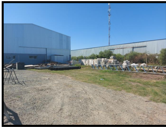
Figura N°19: Depósito de sobrantes de obras.
