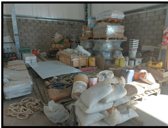
Figura N°7: Depósito de materiales de obra civil.
