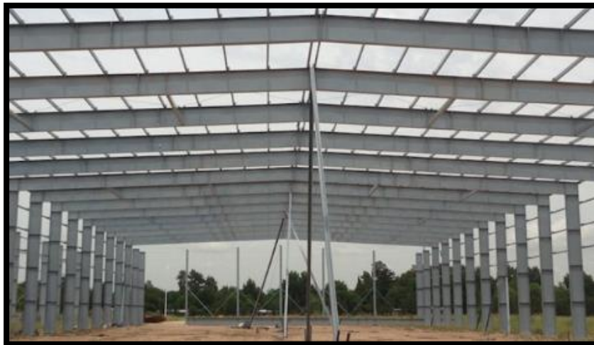
Figura N°40: Estructura de alma llena.
