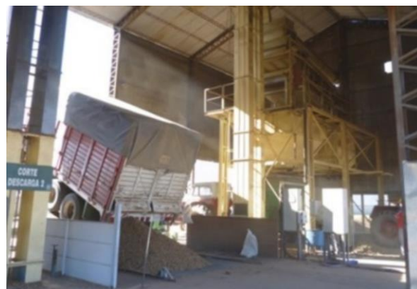
Figura 3-02: Descarga de camiones
