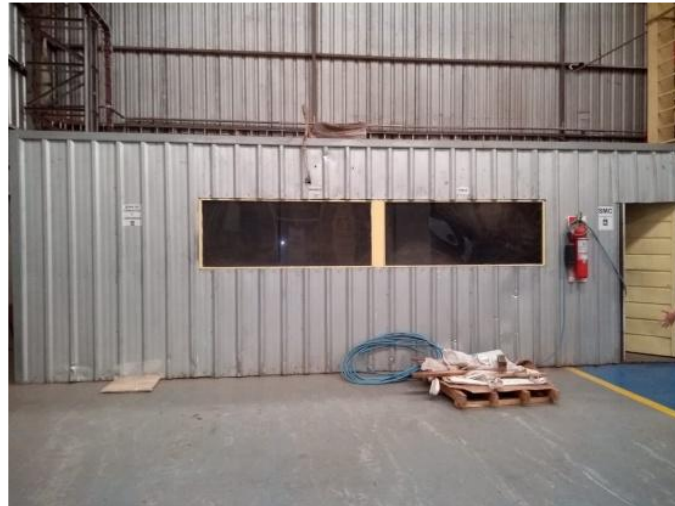
Figura 3-14: Sala de comando
