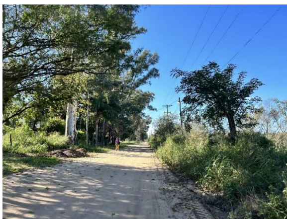
Figuras N°18 y 19: Estado de calles: falta de gálibo y cunetas – Callejón Montenegro Fuente: Relevamiento propio.
