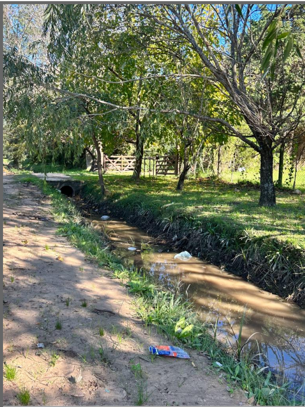
Calle Santa Rosa intersección Callejón Vidal - Acumulación de agua pluvial de lluvias pasadas. Falta de limpieza y mantenimiento. Pendientes deficientes.
