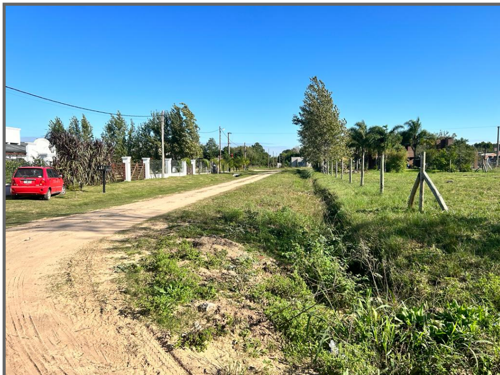
Canal sobre calle Matías Molinas, lado Norte - Falta de mantenimiento
