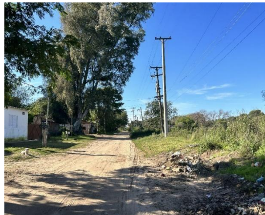
Figuras N°18 y 19: Estado de calles: falta de gálibo y cunetas – Callejón Montenegro Fuente: Relevamiento propio.
