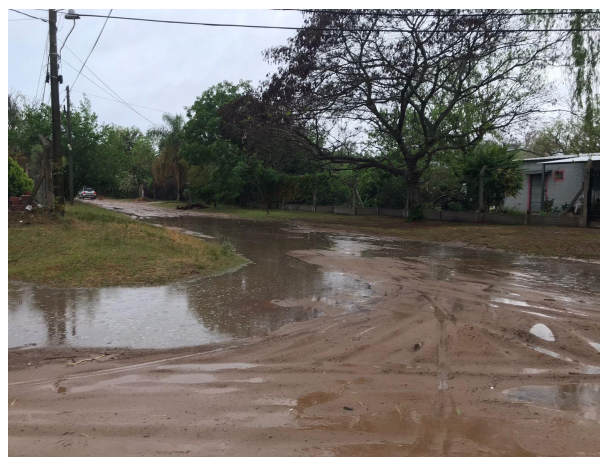
Figuras N°20 y 21: Acumulación de agua en calzadas y cunetas Fuente: Relevamiento propio.
