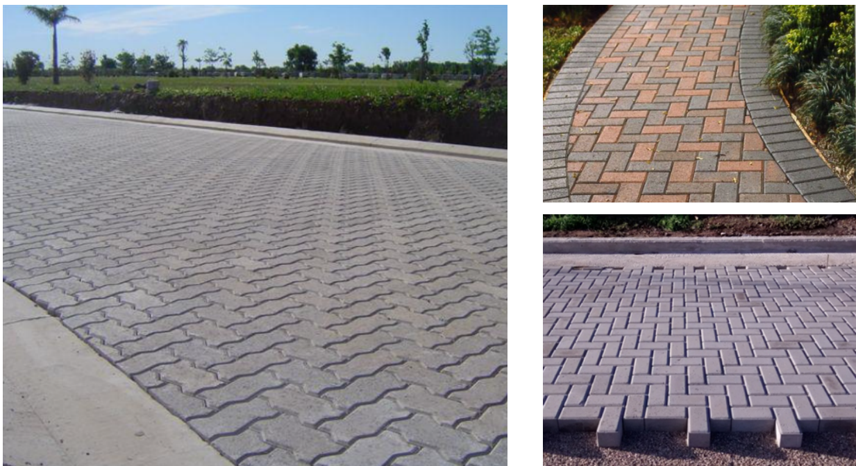
Figura N° 44: Ejemplos de pavimento intertrabado
