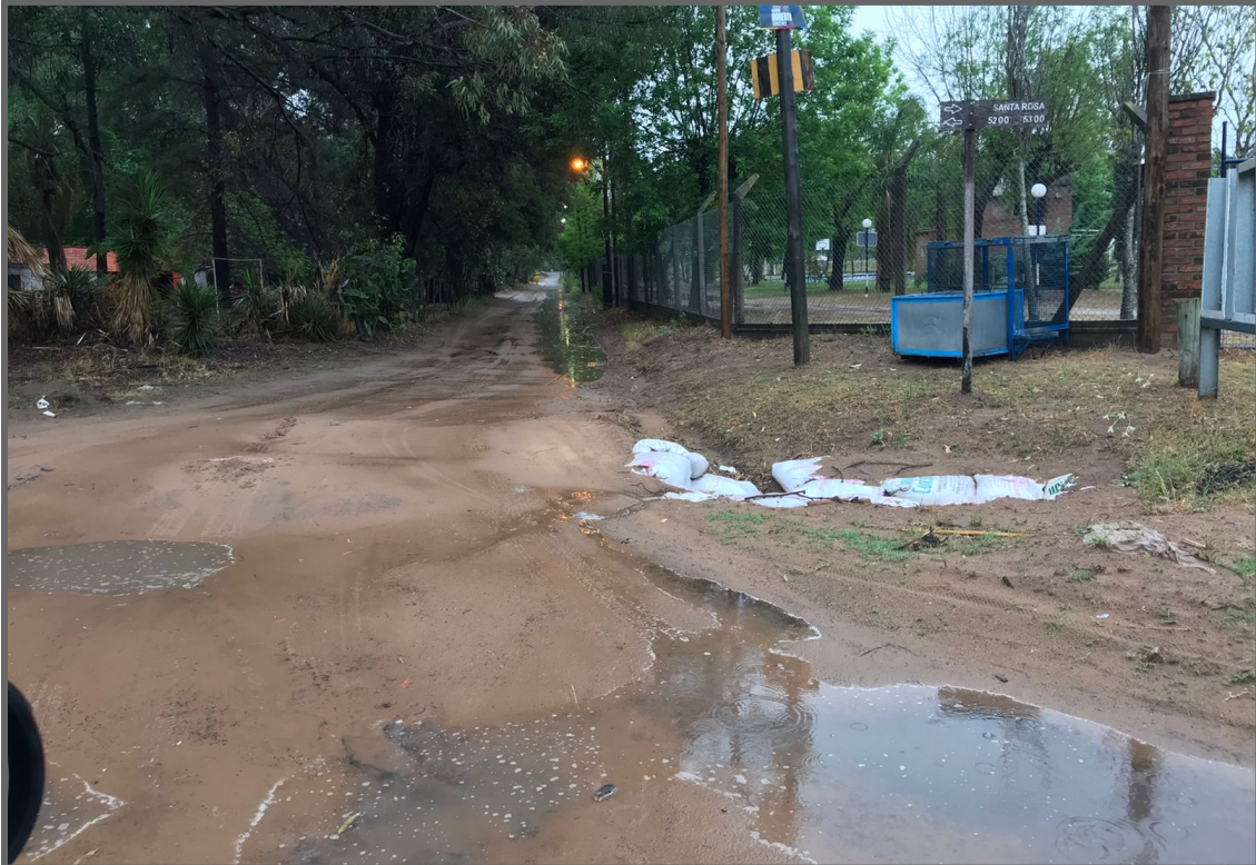
Calle Santa Rosa - Lavado y erosión de suelo - Inaccesibilidad del agua a canales
