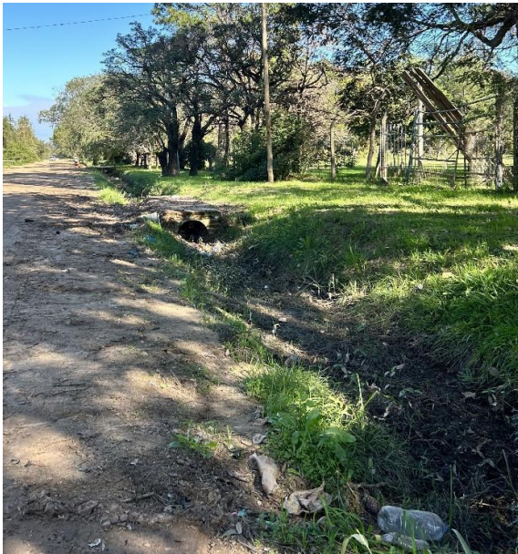
Figuras N° 12 y 13: Falta de mantenimiento en canales – Calle Santa Rosa. Fuente: Relevamiento propio.
