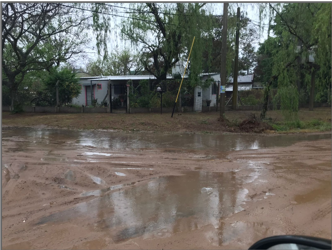
Calle Santa Rosa- Anegamientos en calzada. Inexistencia de alcantarillas.
