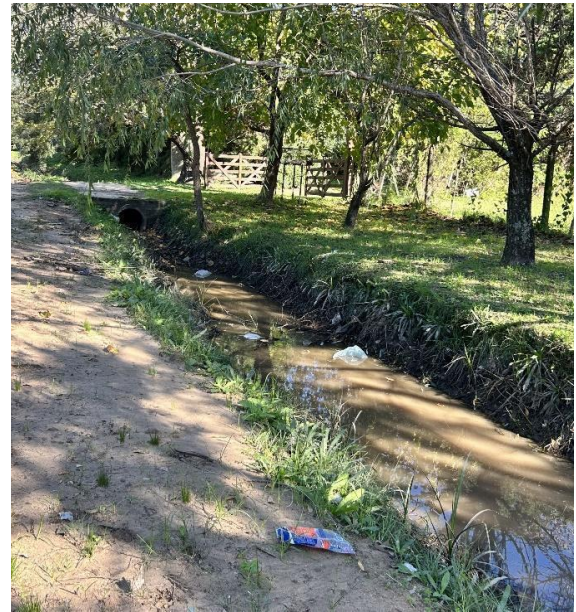
Figuras N° 12 y 13: Falta de mantenimiento en canales – Calle Santa Rosa. Fuente: Relevamiento propio.
