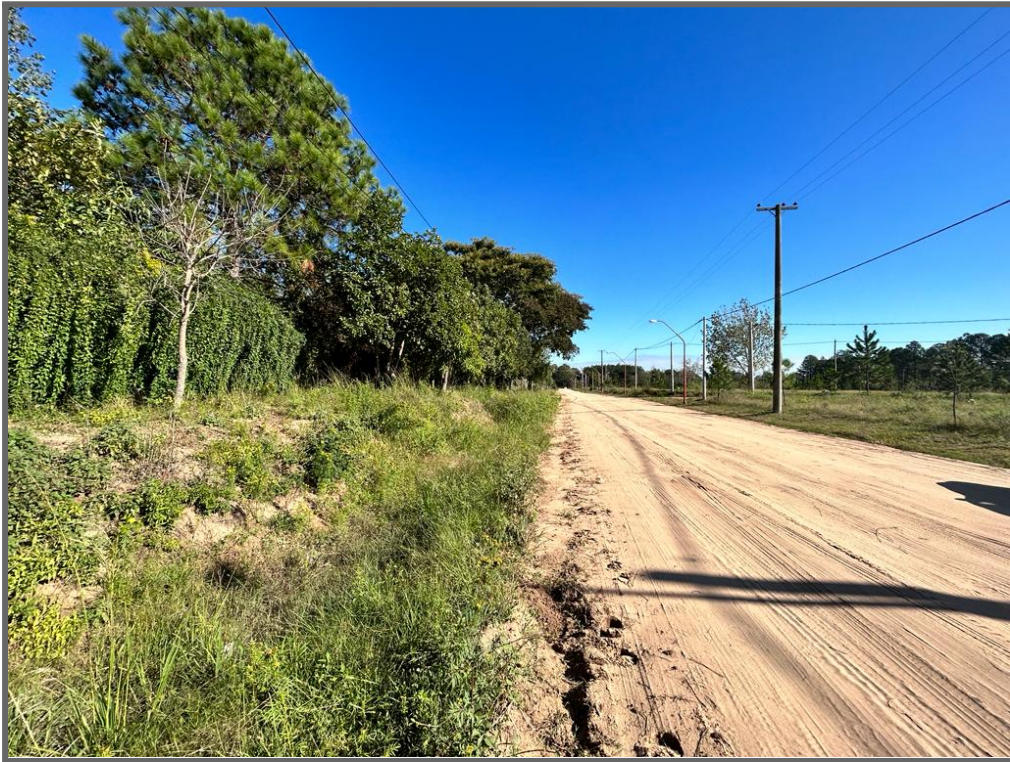
Canal colector Callejón Vidal y Callejón Marcos Mendieta - Lado sur.
