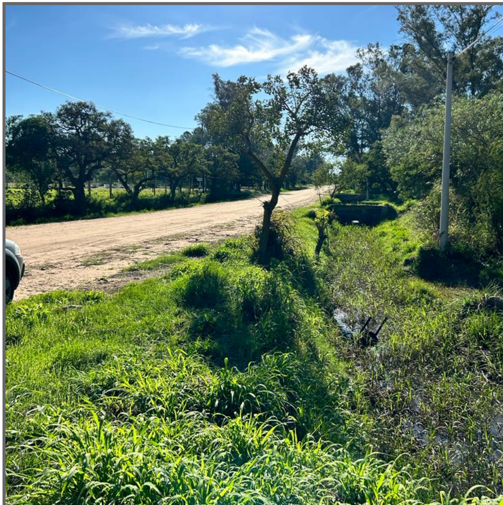
Canal Este - Calle Santa Rosa y Callejón Pintos
