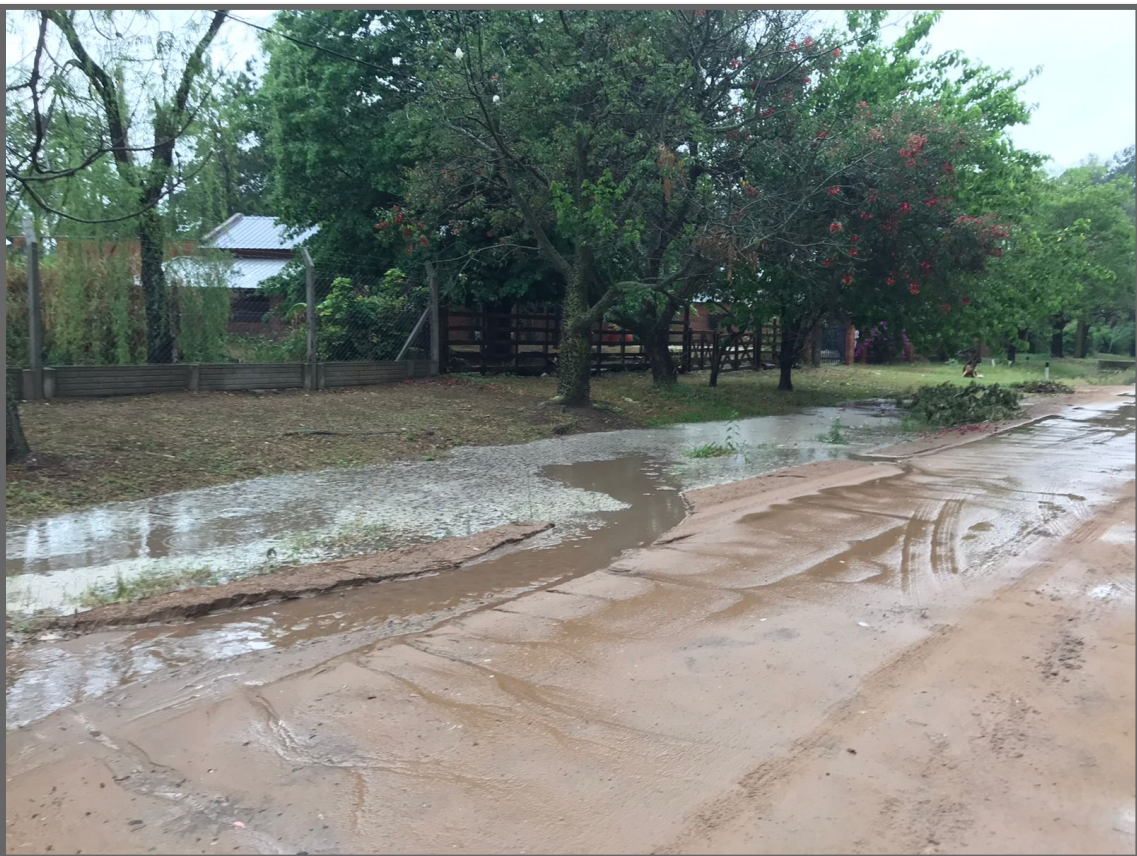
Calle Santa Rosa intersección Callejón Vidal - Saturación de canales y lavado de suelo
