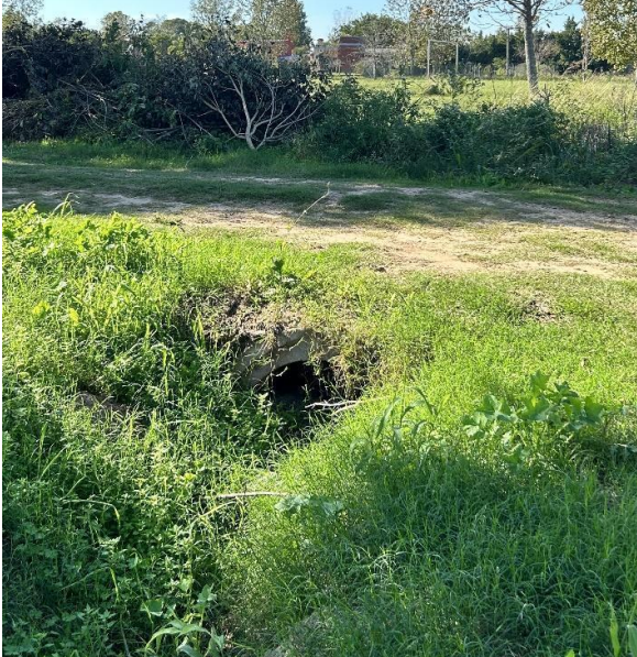
Figuras N°16 y 17: Falta de mantenimiento en zanjas y entubado – Calle Molinas. Fuente: Relevamiento propio.
