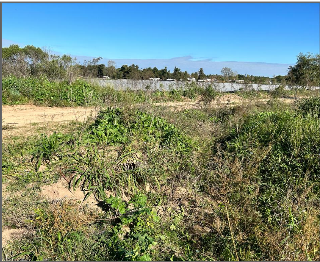
Intersección de calle Matías Molinas y calle Gustavo Cochet - Falta de mantenimiento en canales y conductos.
