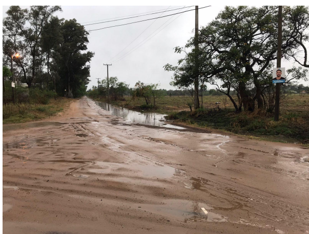
Figuras N°20 y 21: Acumulación de agua en calzadas y cunetas Fuente: Relevamiento propio.
