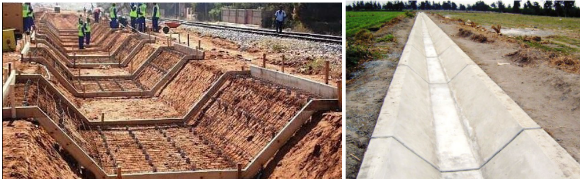
Figura N° 36: Canales trapeziales de H°A° fabricados in situ
