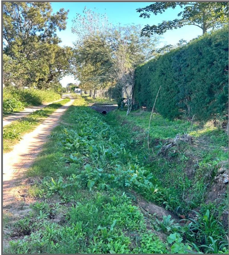
Canal sobre calle Matías Molinas, lado Norte - Falta de mantenimiento
