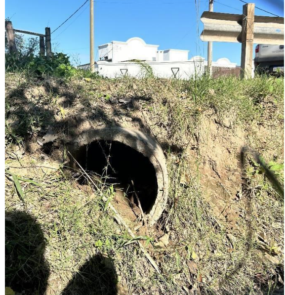
Figuras N°16 y 17: Falta de mantenimiento en zanjas y entubado – Calle Molinas. Fuente: Relevamiento propio.
