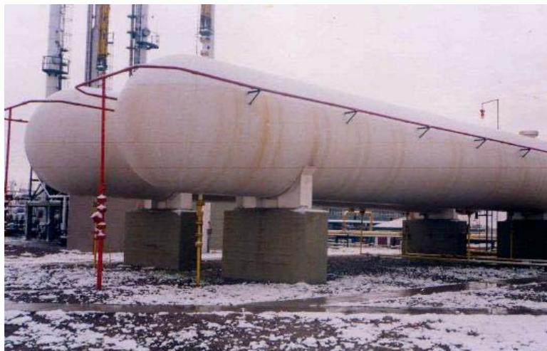
Figura 1. Recipiente Contenedor de Presión Horizontal
