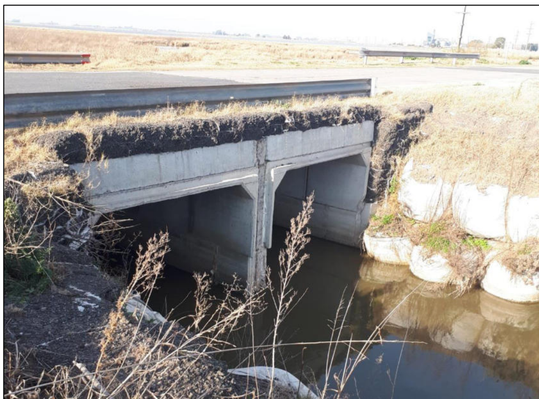
Figura N°E5: Imagen de obra N°4.
