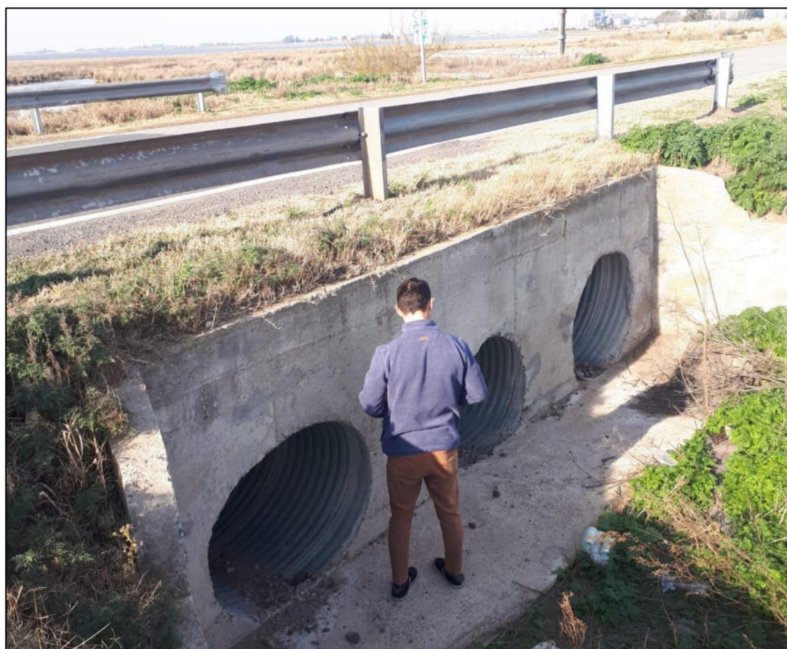
Figura N°E6: Imagen de obra N°5.
