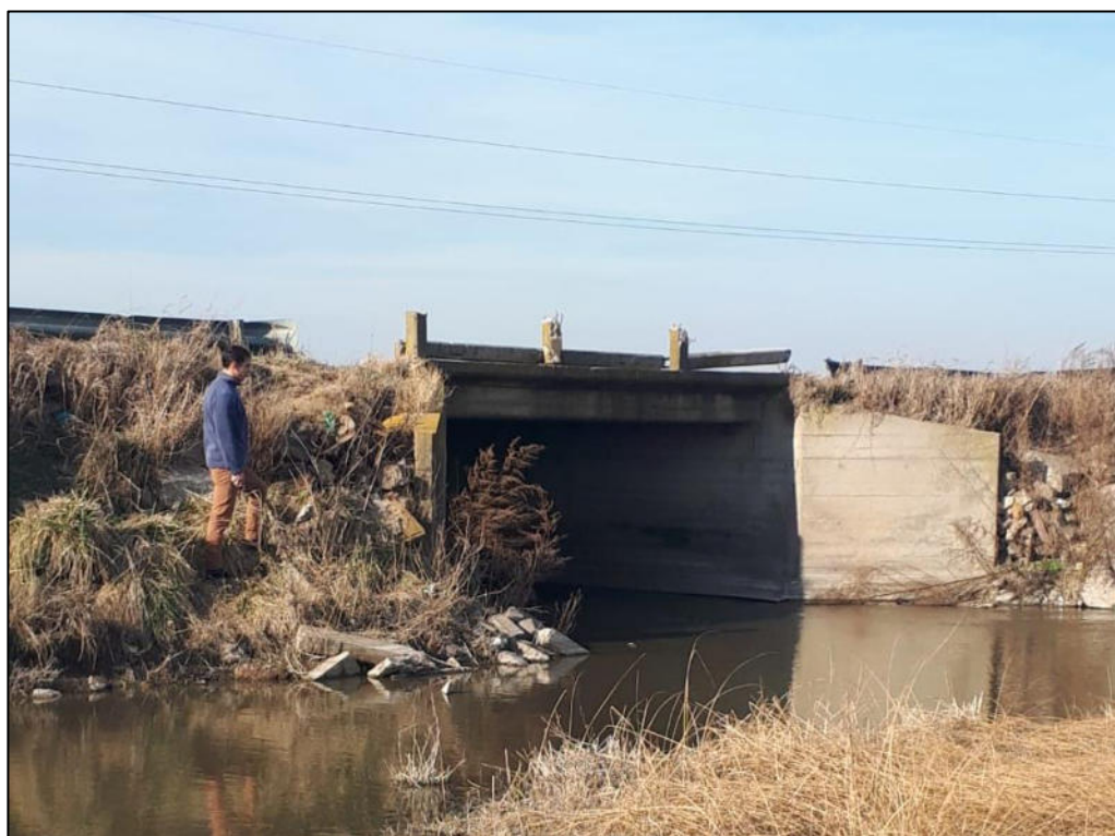
Figura E2: Imagen de obra N°1.
