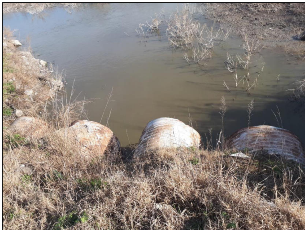
Figura N°E4: Imagen de obra N°3.
