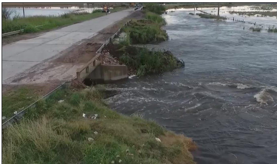
Figura N°E7: Escorrimento del agua en secciones de control para el evento diciembre 2016-enero 2017.
