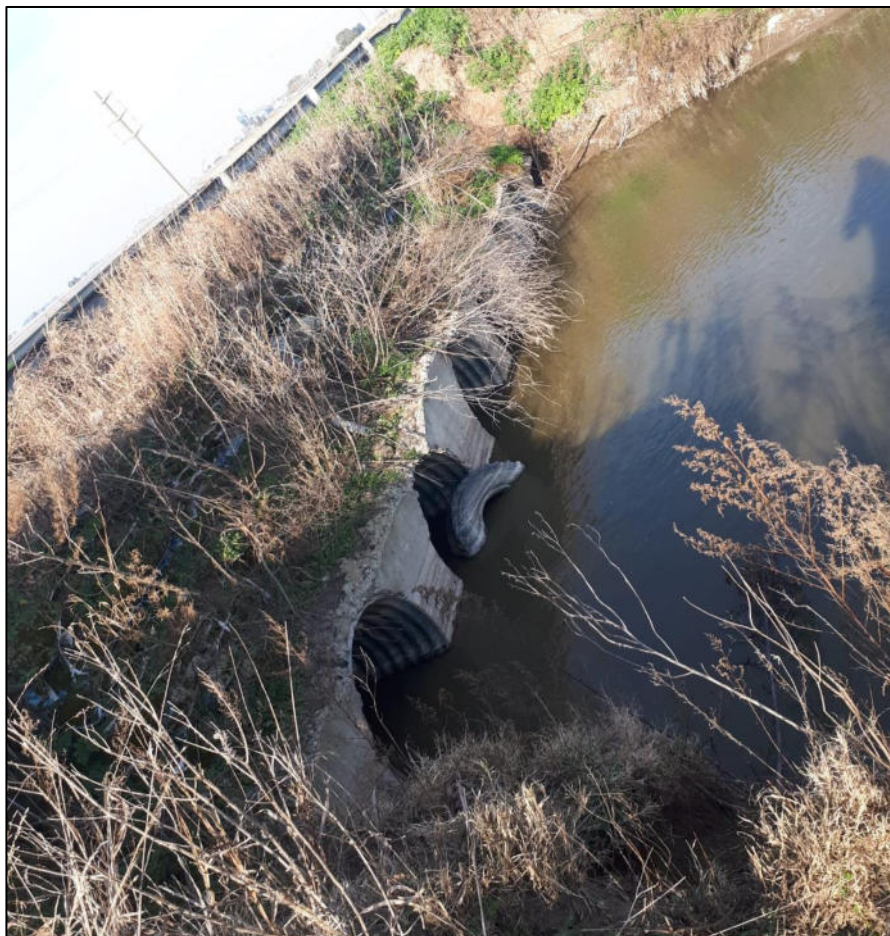
Figura N°E3: Imagen de obra N°2.
