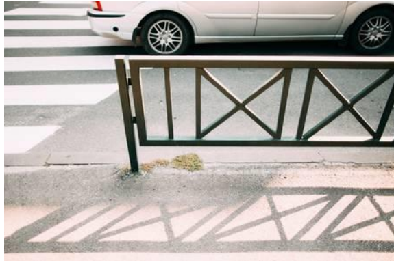
Figura 108. Barrera para encauce peatonal. Fuente: Imagen obtenida de Internet
