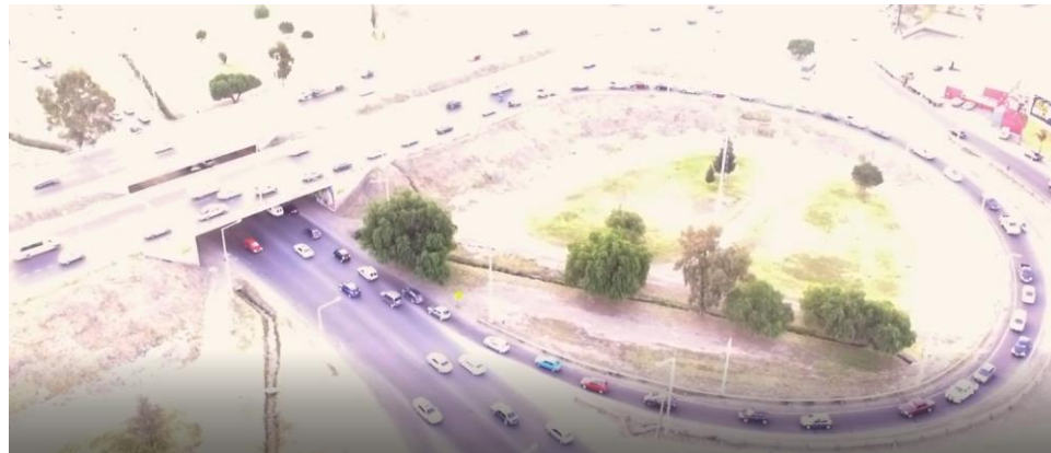
Figura 53. Afectación cola de Carril Rodríguez Peña en Acceso Sur. Fuente: Elaboración Propia
