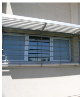
Figura 14: Fotografías biblioteca pública Lavalle, imágenes diseño de carpintería y aleros hacia el norte
