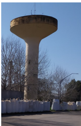
Figura 15.1.1: Torre de almacenamiento de agua potable
