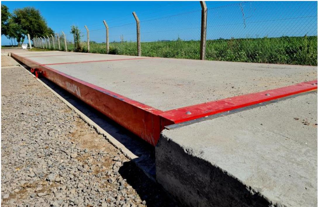
*Ilustración 11- Bascula para pesado de camiones.<sup>5</sup>*
