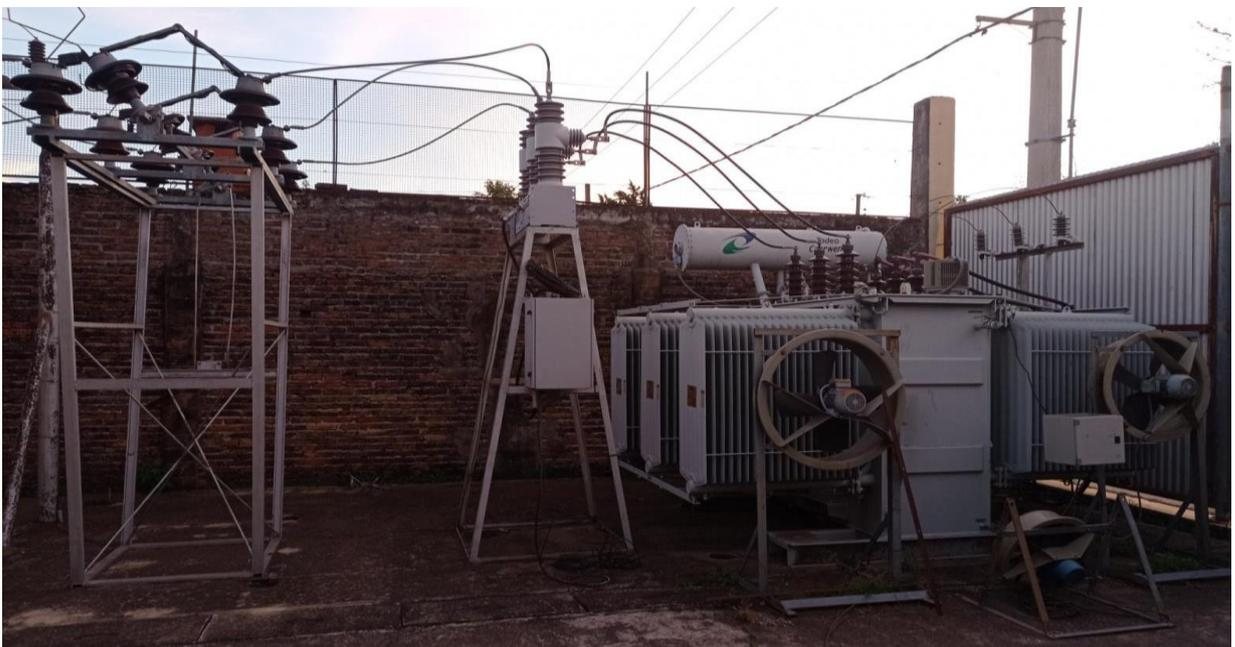
**Ilustración 5 - Transformador 5 MVA**
