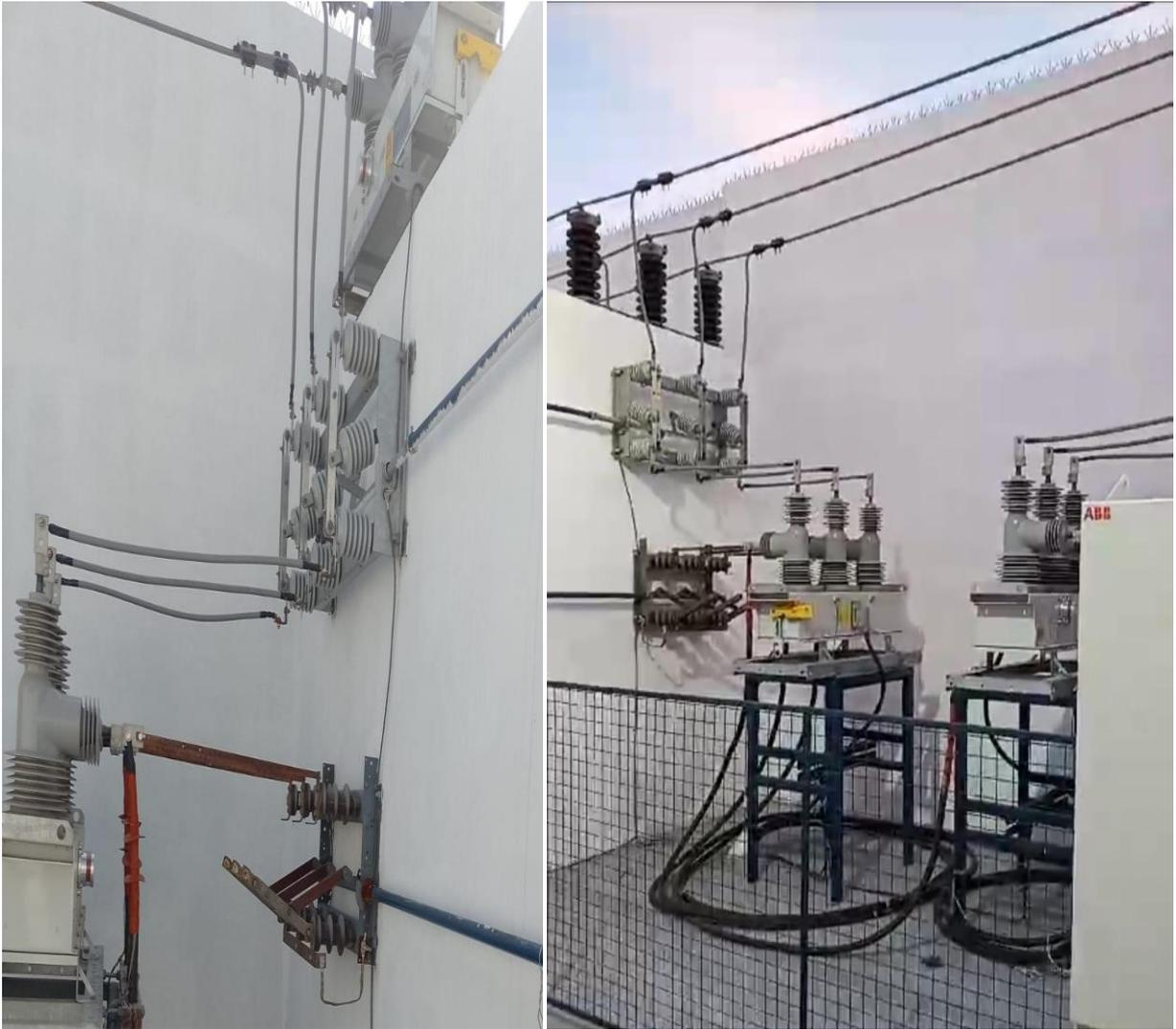
**Ilustración 9 - Reconectores y seccionadores para los transformadores.**
