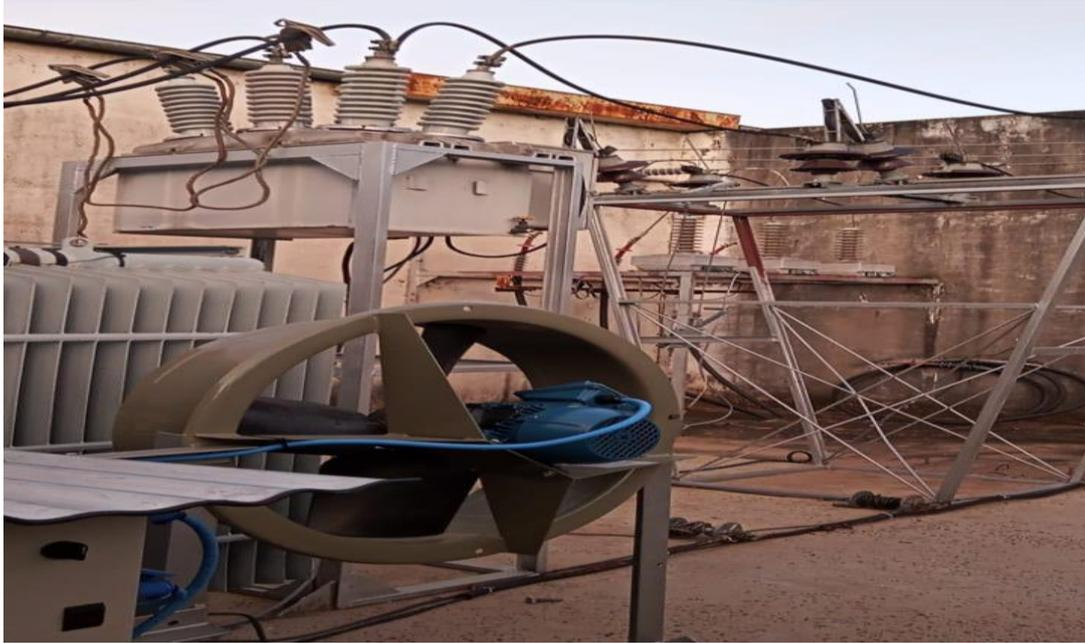
Ilustración 6 - Ventilador de Transformador T8
