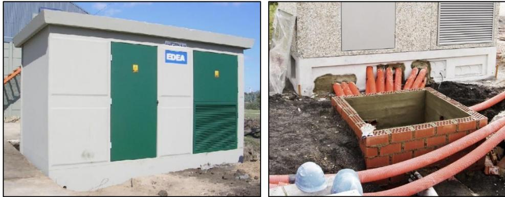
*Figura IB LSMT-4: Centro de transformación y cámara de inspección.*
