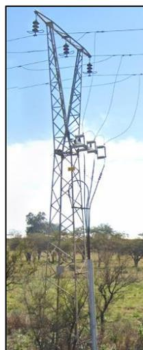
Figura IB LSMT-3: Acometida aérea-subterránea.
