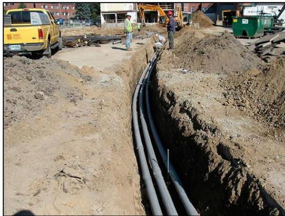
*Figura IB LSMT-1: Línea subterránea de media tensión (LSMT).*
