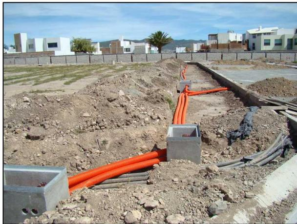
*Figura IB LSBT-1: Línea subterránea de baja tensión (LSBT).*
