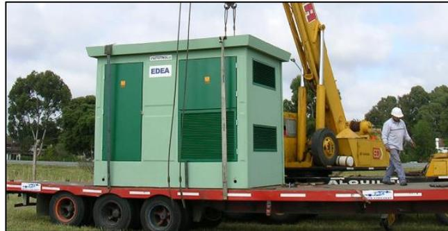
*Figura IB LSMT-24: Cabina prefabricada de hormigón.*
