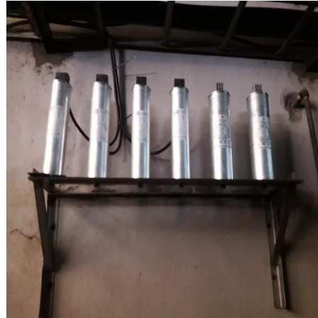
4 \times 15 = 60 \text{ kVAR} conector al tablero automático y 2 \times 15 \text{ kVAR} sin conectar
