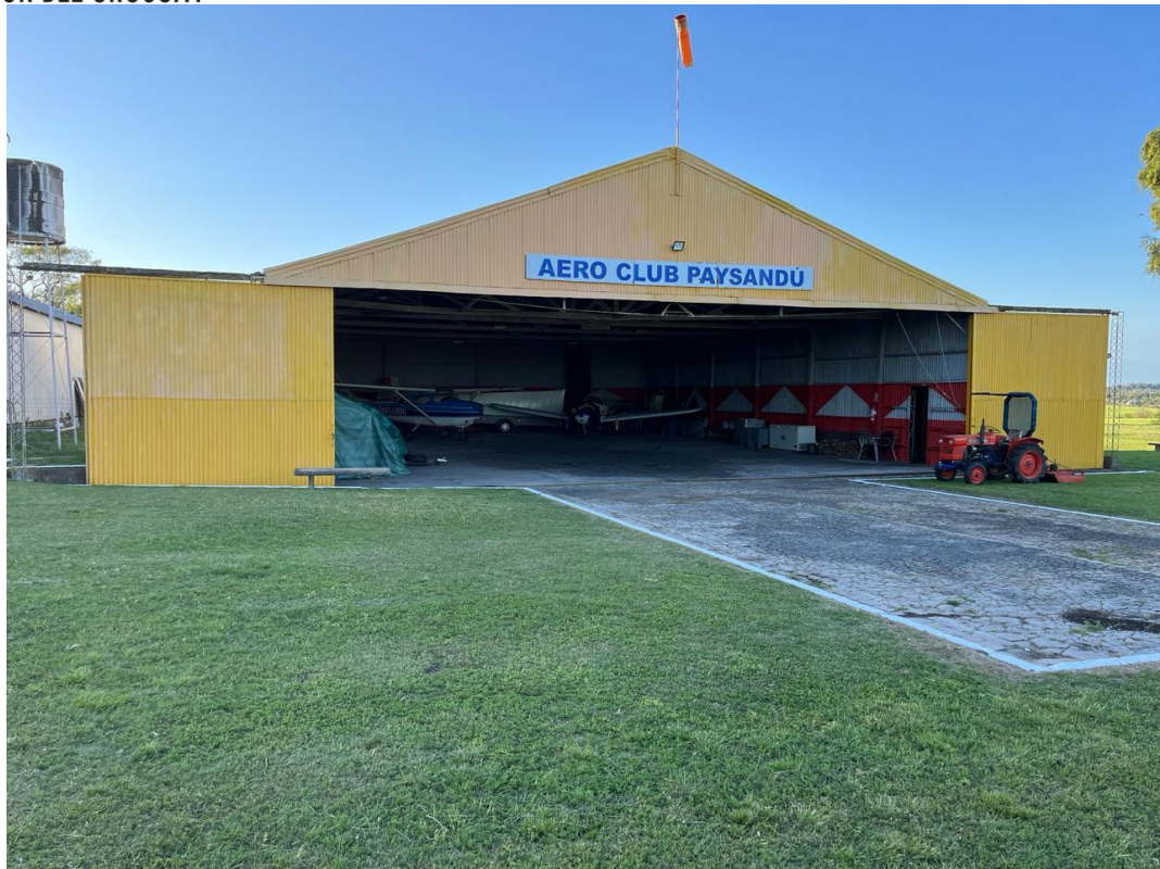
Figura 71. Hangar 2 del Aero Club Paysandú. Fuente: Elaboración propia, 2023.
