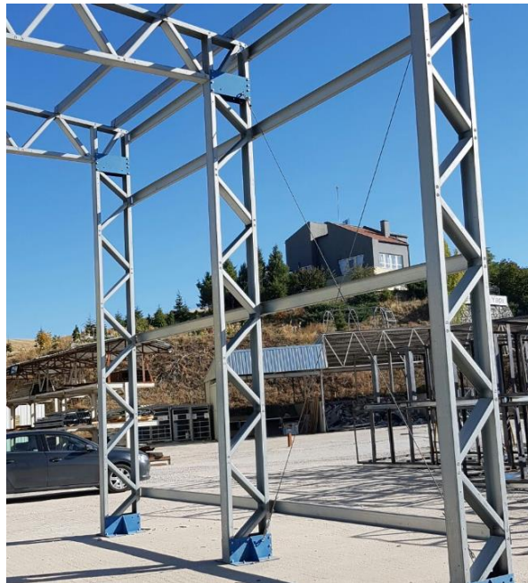
Figura 101. Columnas y perfiles estructurales.
