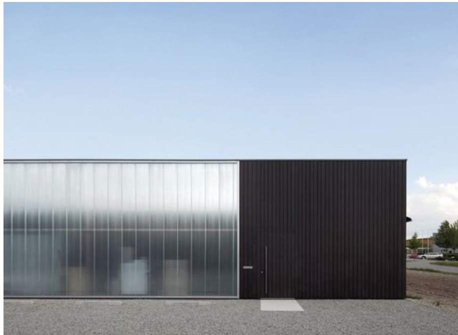
Figura 107. Muro cortina traslucido.
