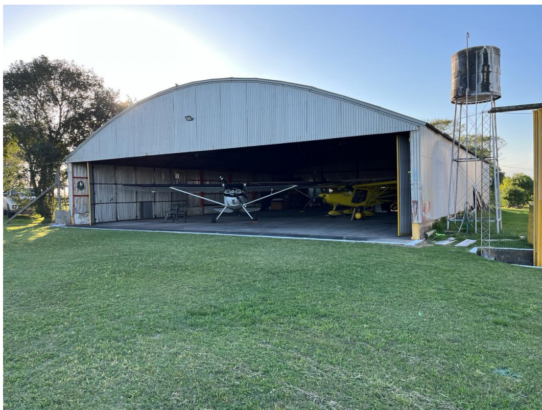
Figura 70. Hangar 1 del Aero Club Paysandú. Fuente: Elaboración propia, 2023.
