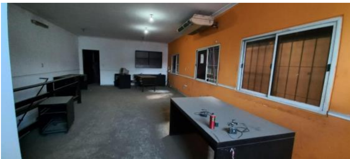
Imagen de taller galpón interior zona oficinas.
