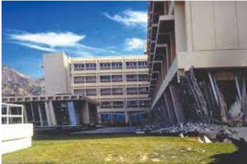
Figura 2.1. Fotografía del Hospital Olivie View de Los Ángeles, después el terremoto de San Fernando en 1971.
