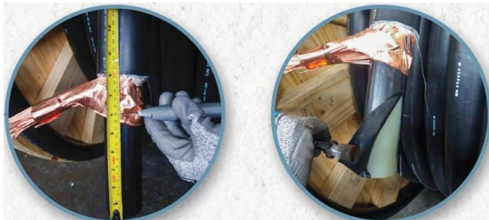
*Ilustración 131. Segunda capa semi-conductora*
