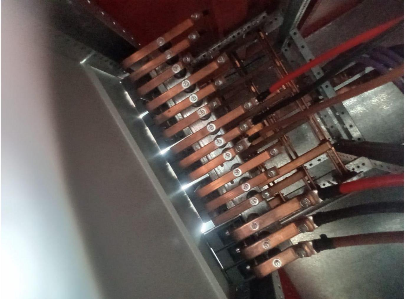
Esas barras que se ven son solo extensiones que salen derecho de los interruptores termomagnéticos, se utilizan por una cuestión de no andar conectando y desconectando del borne del interruptor, lo cual puede provocar que el borne se deforme y haya que cambiar el interruptor, y para eso hay que organizar un corte con el resto de los sectores afectados a ese transformador.
