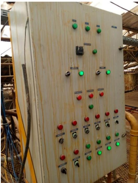
Imagen 6. Cables expuestos, con desgaste por fricción. Se observa filtración de agua en tablero eléctrico
