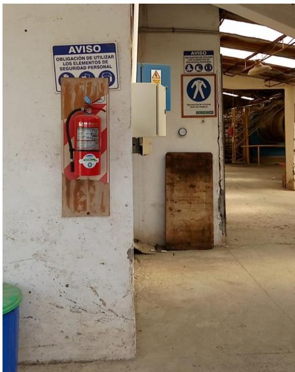
Imagen 9. Chapa baliza deteriorada, cartelería fuera de lugar.
