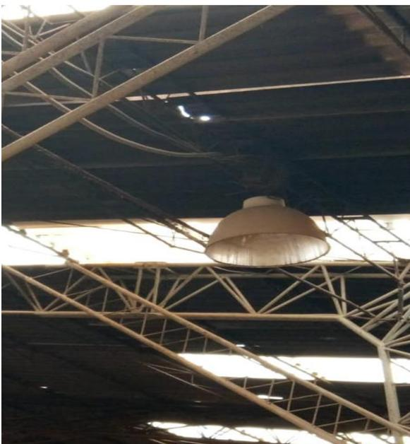
*Imagen 3. Luminaria en malas condiciones.*
