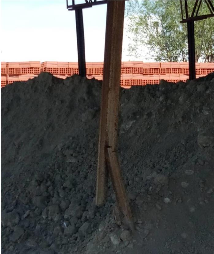
Imagen 22. Estructura de soporte de techo a punto de quebrarse.
