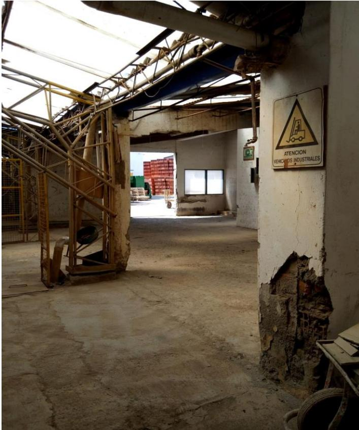
Imagen 28. Columnas de hormigón en mal estado.
