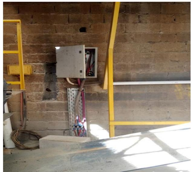
*Imagen 2. Caja de fusibles en malas condiciones.*
