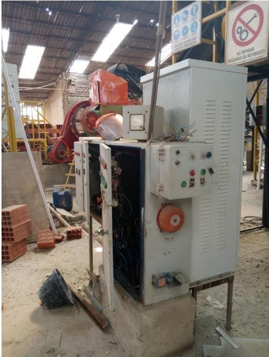
Imagen 5. Tableros eléctricos abiertos y en mal estado.
