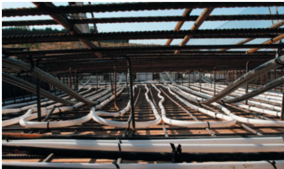
FIGURA 13 Tubos de activación sobre la armadura de fondo de una losa
