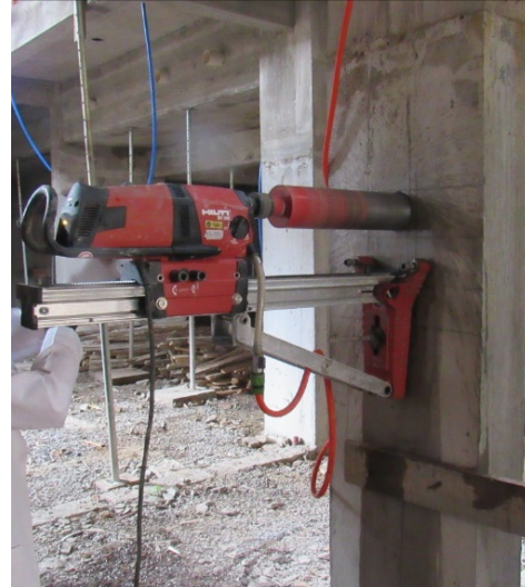
Figura 2: Extracción de testigos en pilar de hormigón armado.
