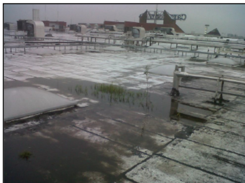
Figura 1: Vista de la cubierta en estudio.
