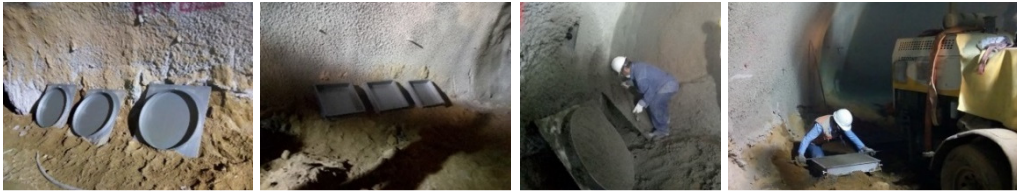
Figura 9: Muestreo de paneles cuadrados y circulares en obra.
