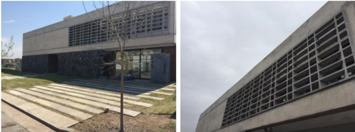
Figuras 6 y 7: Fachada con sistema prefabricado.
