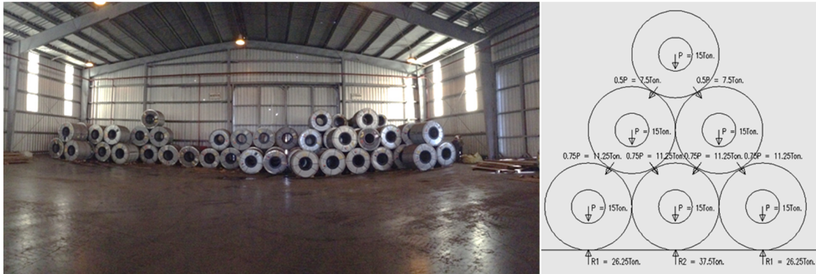
Figure 3: Depósito para almacenamiento de grandes bobinas de acero, construido sobre sobre una sub-base de baja capacidad portante (Dock Sud, 2017).
