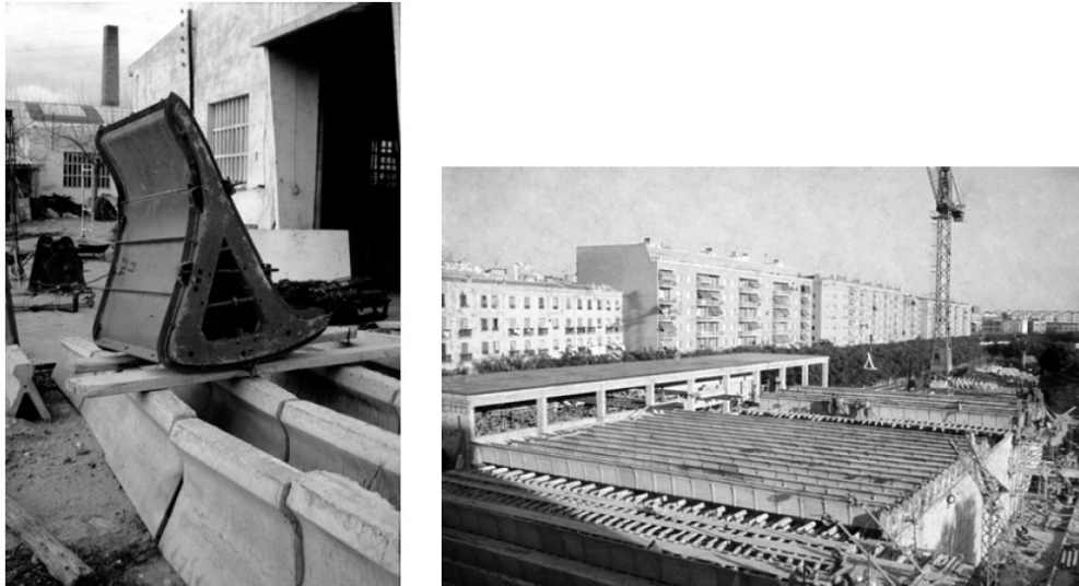
Figura 1 y 2: Proceso de fabricación y montaje de las vigas (imágenes archivo Barredo – Los huesos de Fisac. La búsqueda de la pieza ideal)
