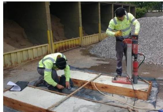
Fotografía 2: extracción de testigos de las losas.
