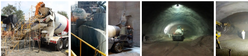
Figura 1: Procedimiento de colocación de revestimiento primario del túnel L-12.
