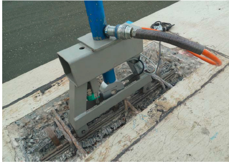
Figura 7: Aplicación en obra del método de la ballesta.
