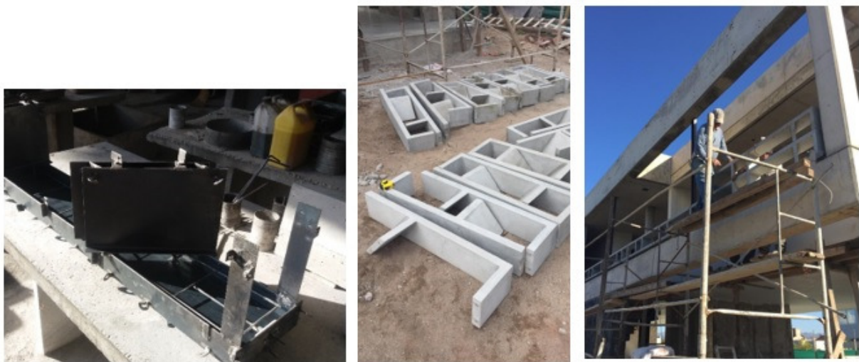
Figuras 8, 9 y 10: Molde metálico. Módulo de pieza prefabricada. Colocación y armado de fachada.
