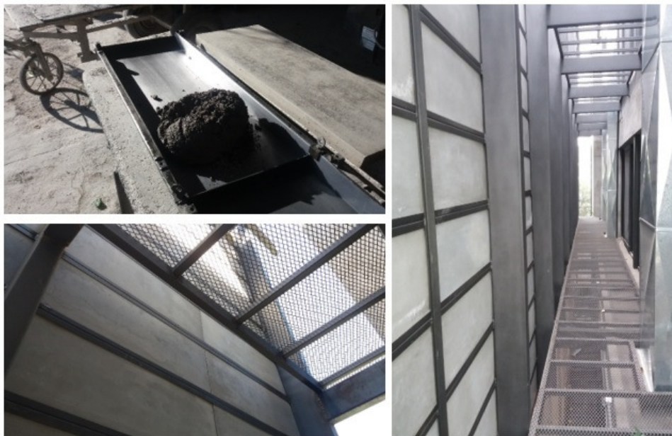
Figuras 14, 15 y 16: Fachada sur, detalles constructivos.
