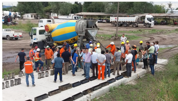
Figura 2: Día de hormigonado.
