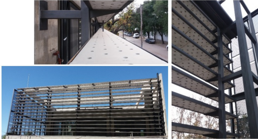
Figuras 11, 12 y 13: Fachada norte, detalles constructivos.
