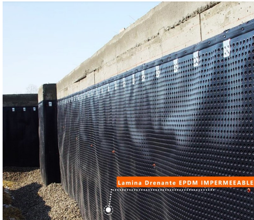
Colocación de Membrana de Polietileno de Alta Densidad (HPDE) en muros de contención
