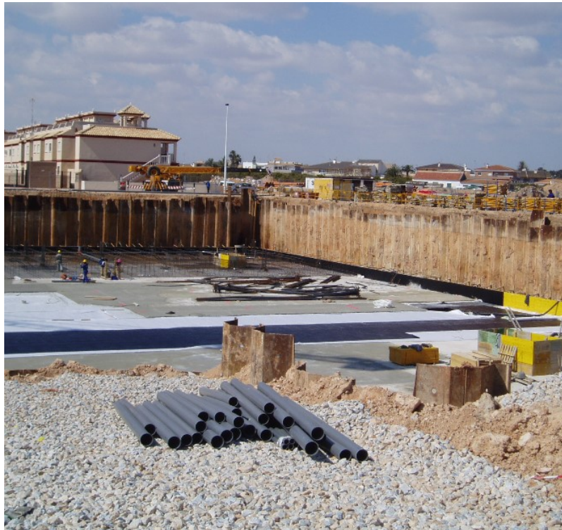
Empleo de tablestacas de acero en configuración de pantalla, permitiendo la excavación de todo el conjunto.
