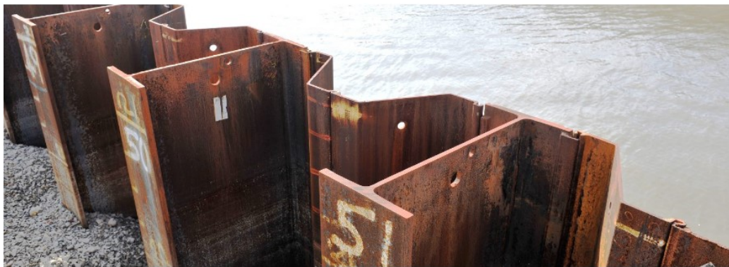
Sistema de tablestaca de acero HZ-M o COMBIWALL HZ
