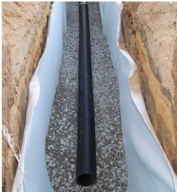
Sistema de drenaje implementado en el proyecto
