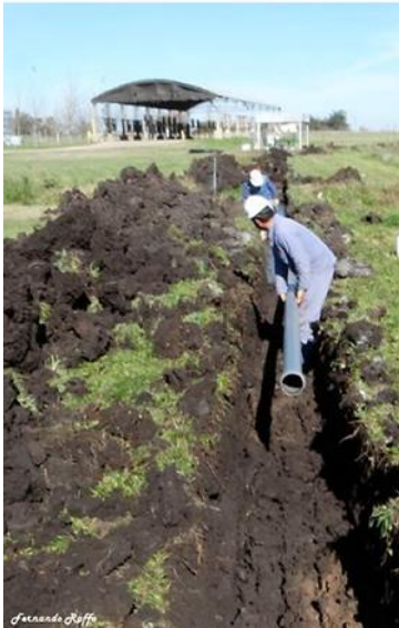
Tendido de caños
