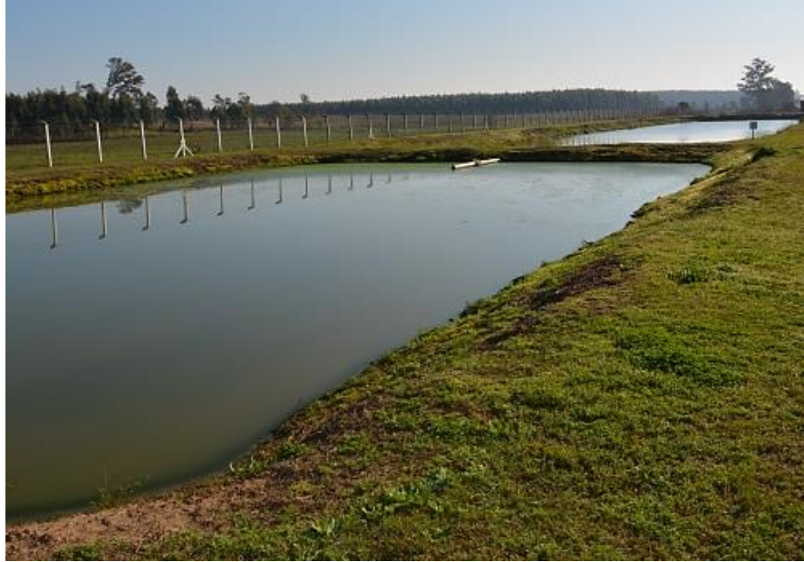
Figura 3.16|Sistema de lagunaje para tratamiento de efluentes.
