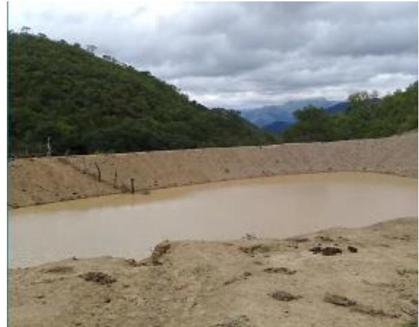
Reservorio de agua
