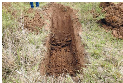
Vista de la excavacion de cateo
