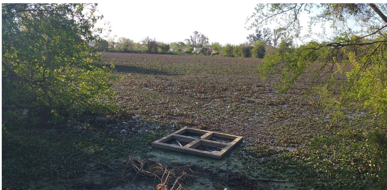
Figura 4 Salida de laguna facultativa existente. (Vista hacia el norte).
