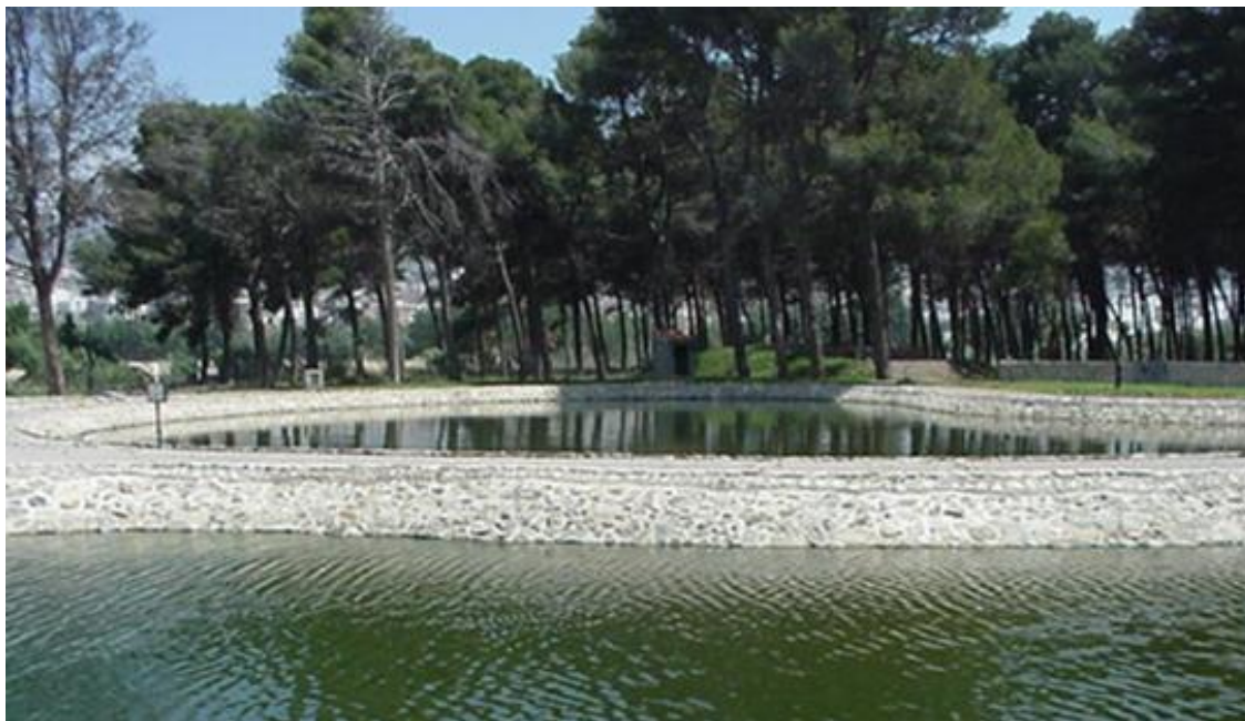
Figura 10 Imagen representativa – Lagunas de estabilización.
