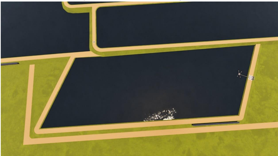
Figura Anexo: A-1.2: Laguna reservorio 1.
