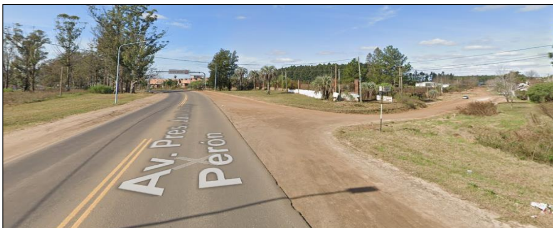
Figura N°20: Fotografía de intersección Av. Pte. Perón y calle Simón Bolívar.
