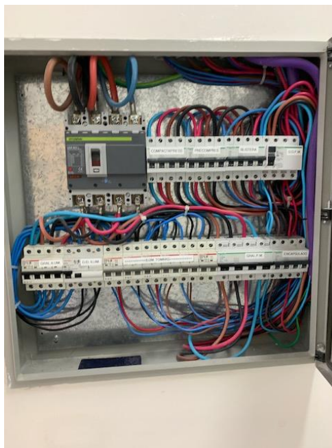
Ilustración 35. Tablero Principal y tablero anexo en desuso
