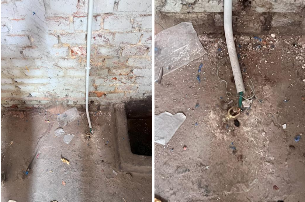
Ilustración 36. Puesta a tierra
