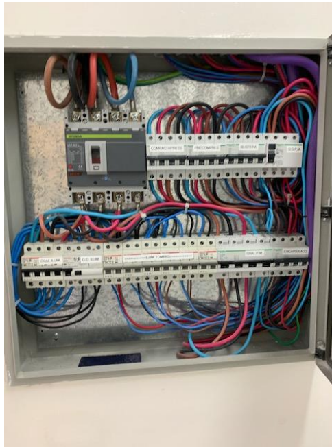
Ilustración 6. Tablero Principal ATT
