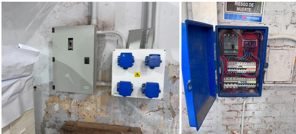
Ilustración 37. Tableros de fuerza auxiliar
