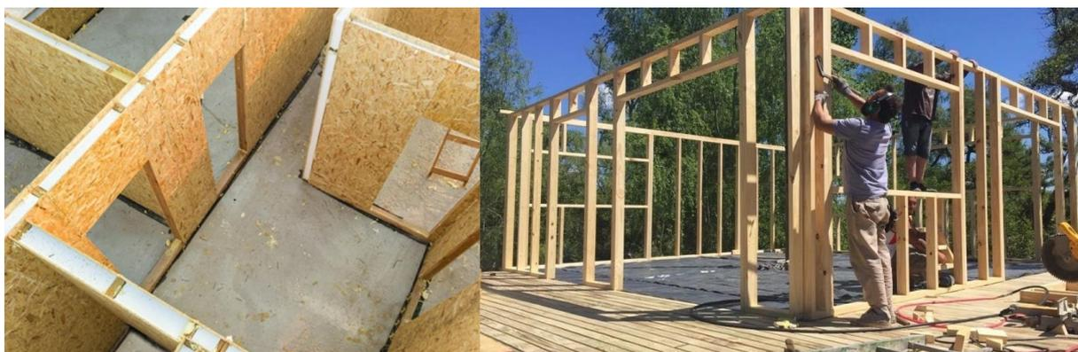
*Ilustración 23: Construcción con paneles SIP (izquierda) y sistema woodframe (derecha). Sistemas constructivos sustitutos al tradicional*
