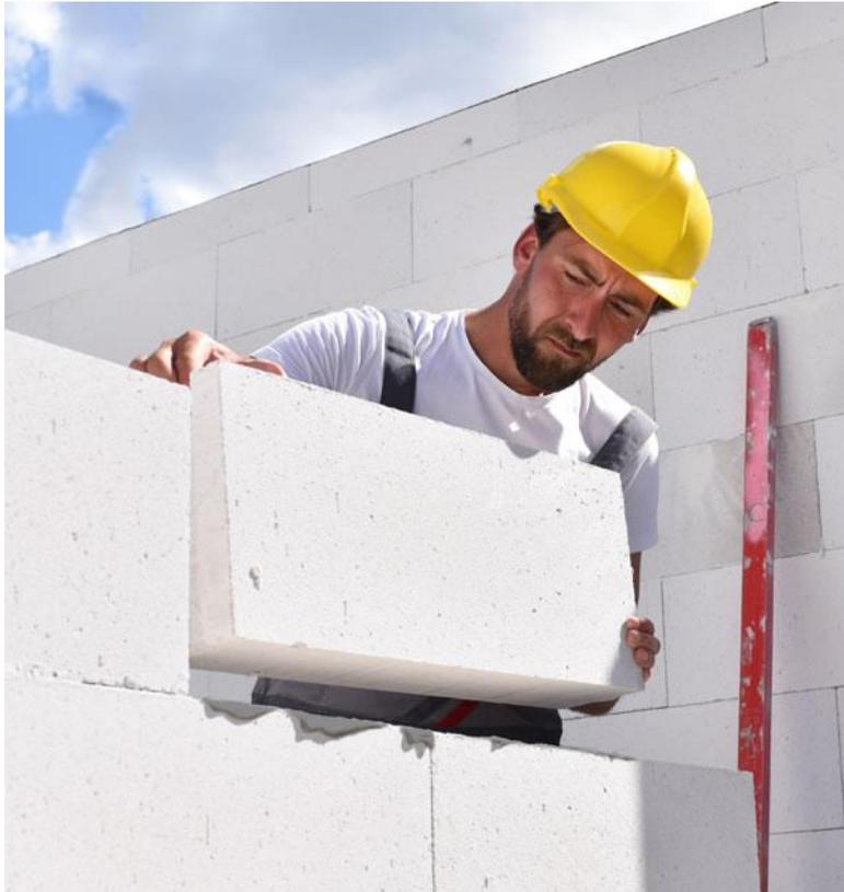
*Ilustración 14: Uso del ladrillo de HCCA (producto sustituto al ladrillo cerámico)*
