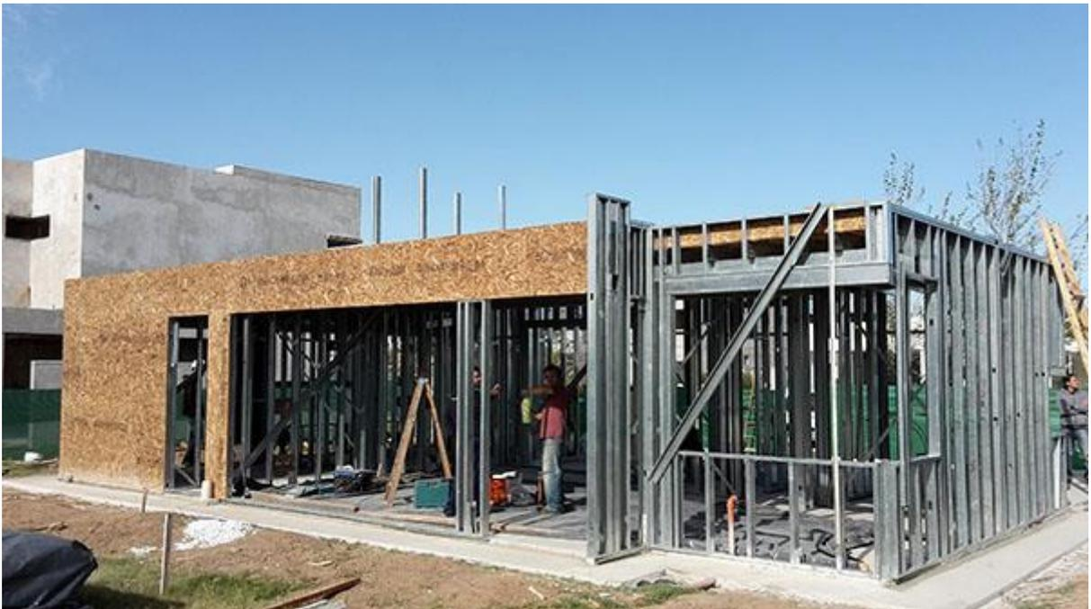
*Ilustración 22: Construcción en seco con sistema steel - frame (sistema sustituto al tradicional)*
