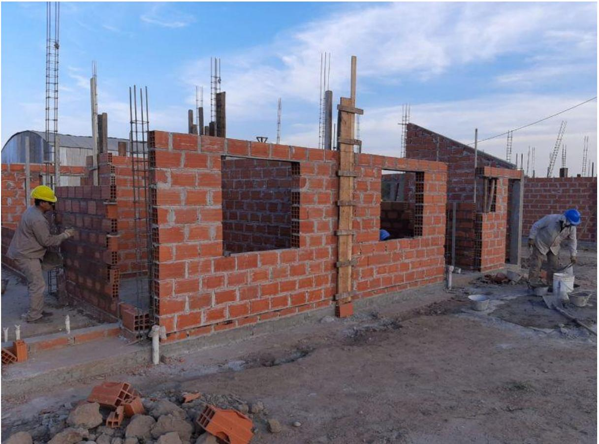
*Ilustración 3: Ejemplo de un barrio de viviendas realizado con ladrillos huecos en Salta*
