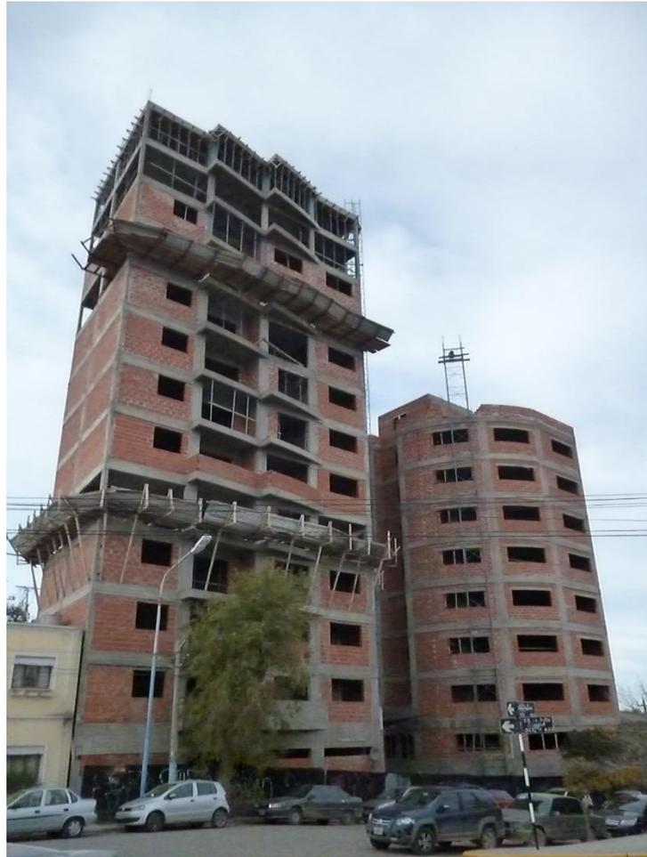
*Ilustración 4: Edificio en altura con mampostería no portante de ladrillos cerámicos huecos*
