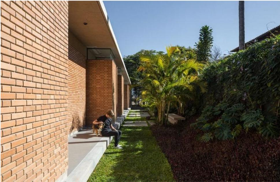
*Ilustración 19: Vivienda con muros exteriores de ladrillos macizos*
