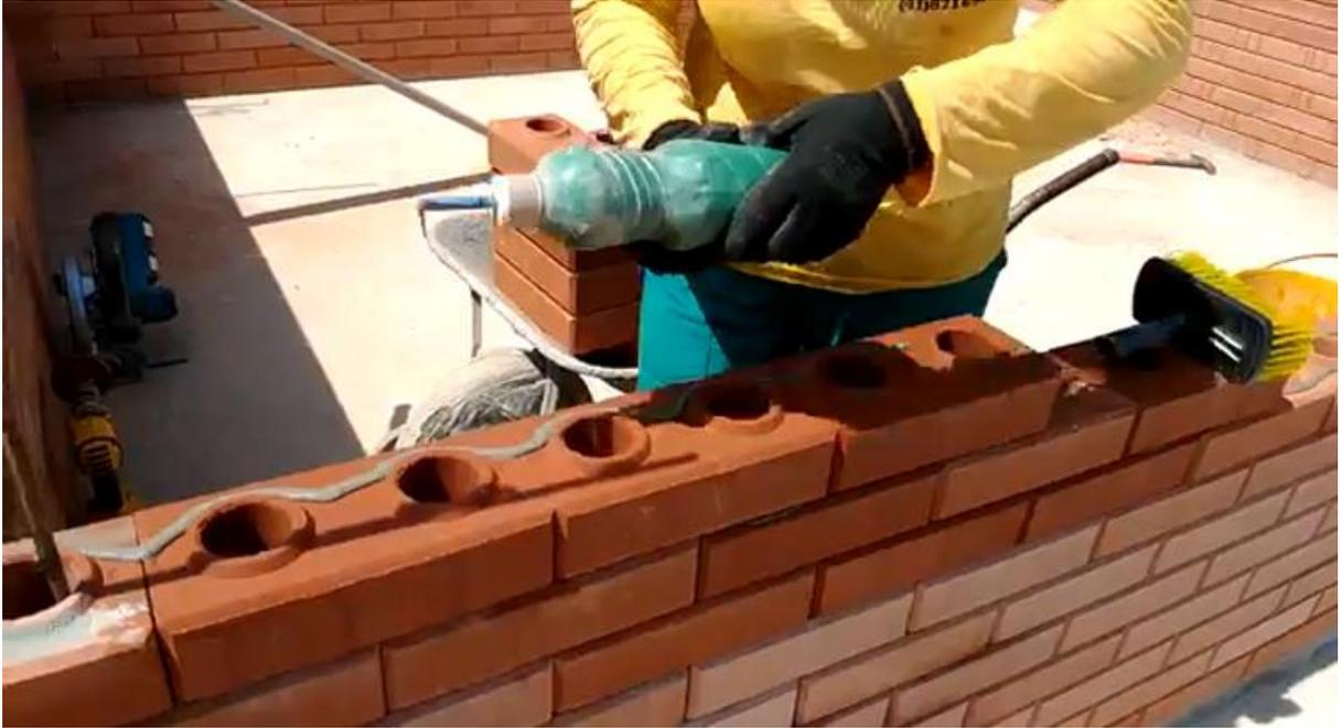
*Ilustración 20: Ladrillos ecológicos elaborados con mezcla de suelo - cemento prensada (producto sustituto al ladrillo cerámico)*
