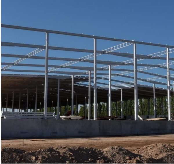
Figura 1.8. Estructura metálica y paneles de cerramiento lateral.
