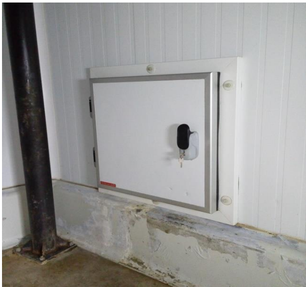
Figura 1.46. Tronerita acceso interior y guía metálica para la eliminación de residuos.
