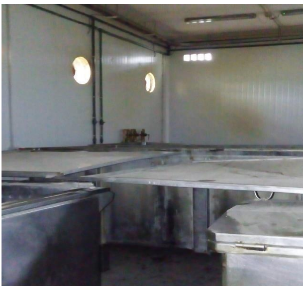
Figura 1.40. Rejillas de ventilación y extractores de aire del sector de cocina.
