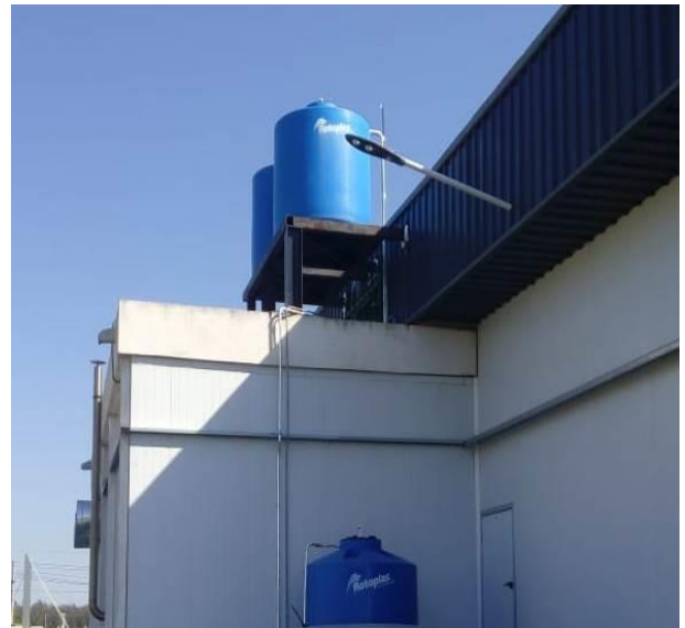
Figura 1.41. Tanque de bombeo y tanques de reserva de agua.
