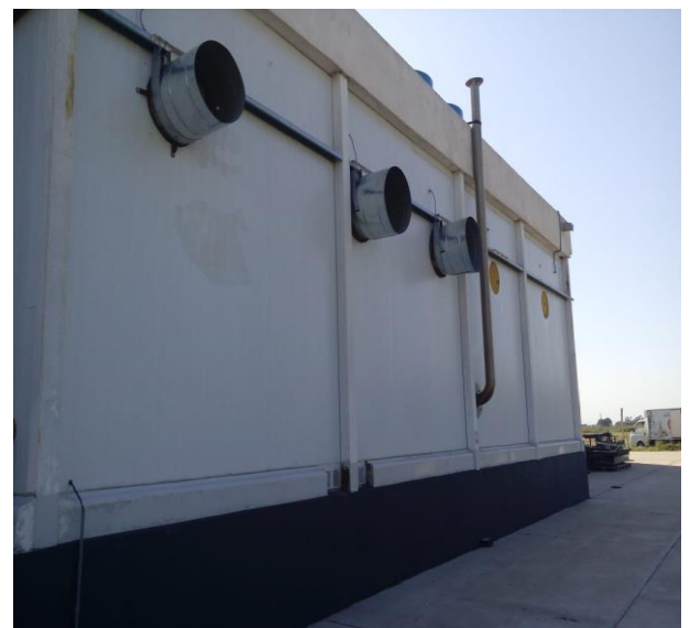
Figura 1.40. Rejillas de ventilación y extractores de aire del sector de cocina.
