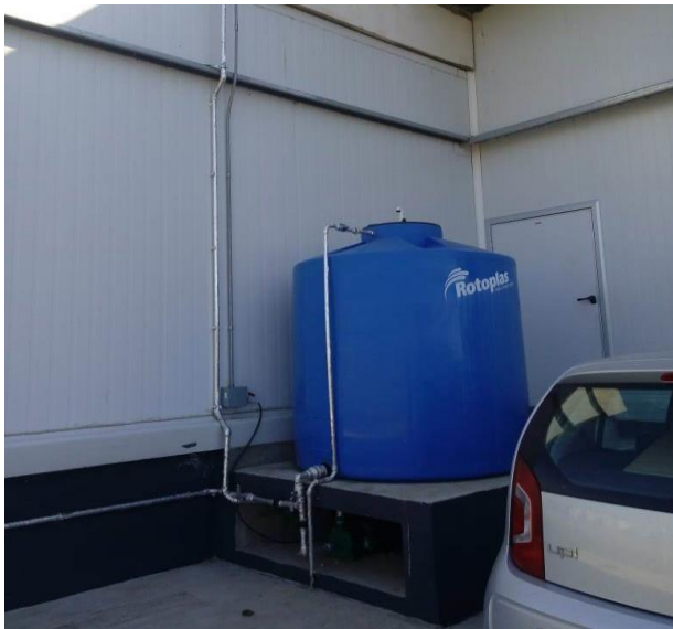
Figura 1.41. Tanque de bombeo y tanques de reserva de agua.
