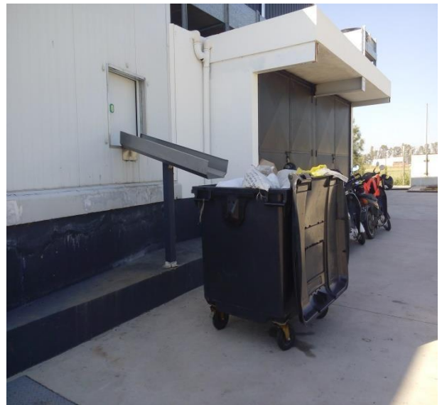
Figura 1.46. Tronerita acceso interior y guía metálica para la eliminación de residuos.
