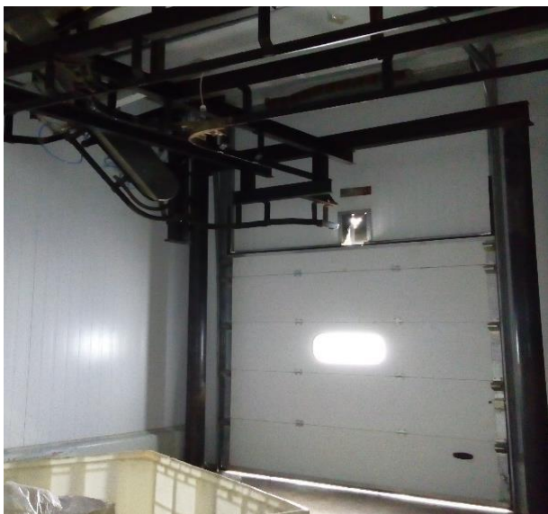
Figura 1.10. Portón marca Arneg con noria elevadora y espacio de antecámara sistema de rieleras.
