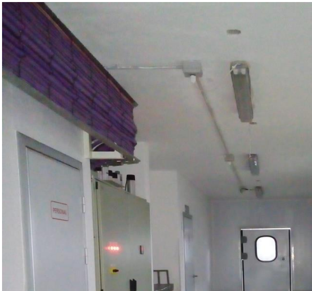
Figura 1.38. Bandejas pasa cable y luminaria principal
