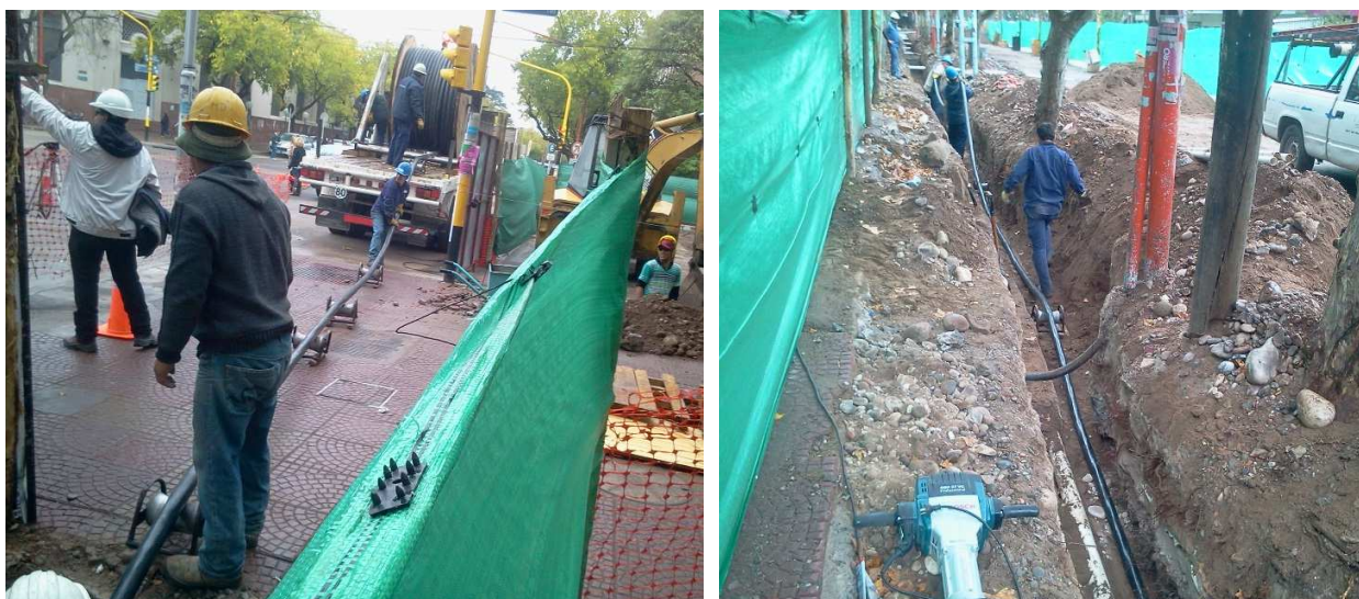
Operarios realizando el tendido de línea de media tensión subterránea
