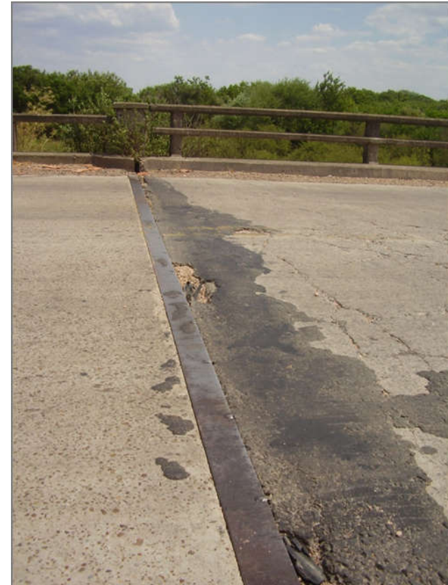
Juntas de dilatación entre tablero y losa de aproximación.
