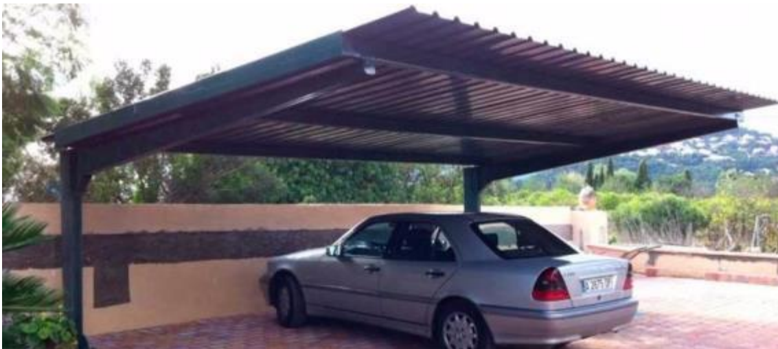
Figura 11.8: Estructura para estacionamiento de autos
