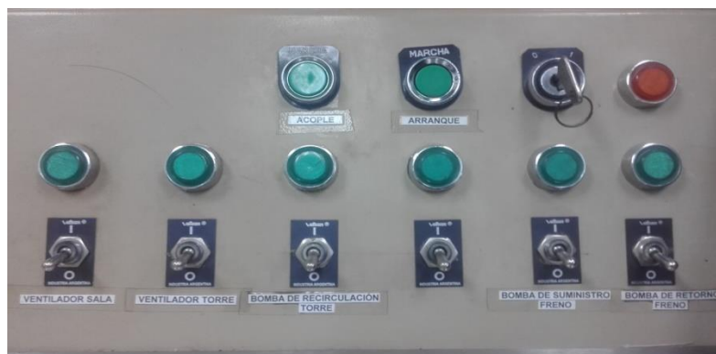
Imagen 36: sistema de refrigeración del agua del motor.
