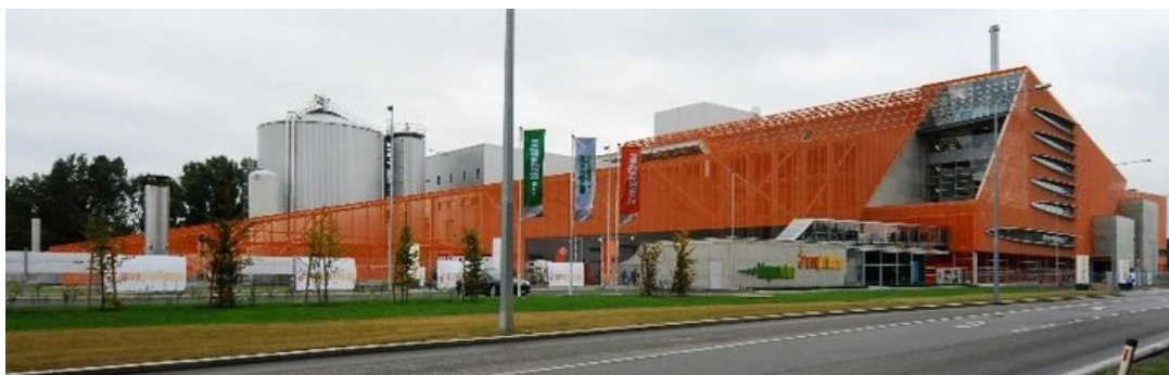
Figura 6. La planta de Pfaffenau, en Viena, Austria
