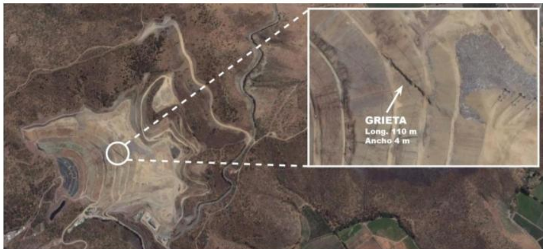
Figura N° 1: Grieta previa a rotura en relleno sanitario Santa Marta, Santiago de Chile – fotografía tomada de la publicación Altabella et al. (2016).
