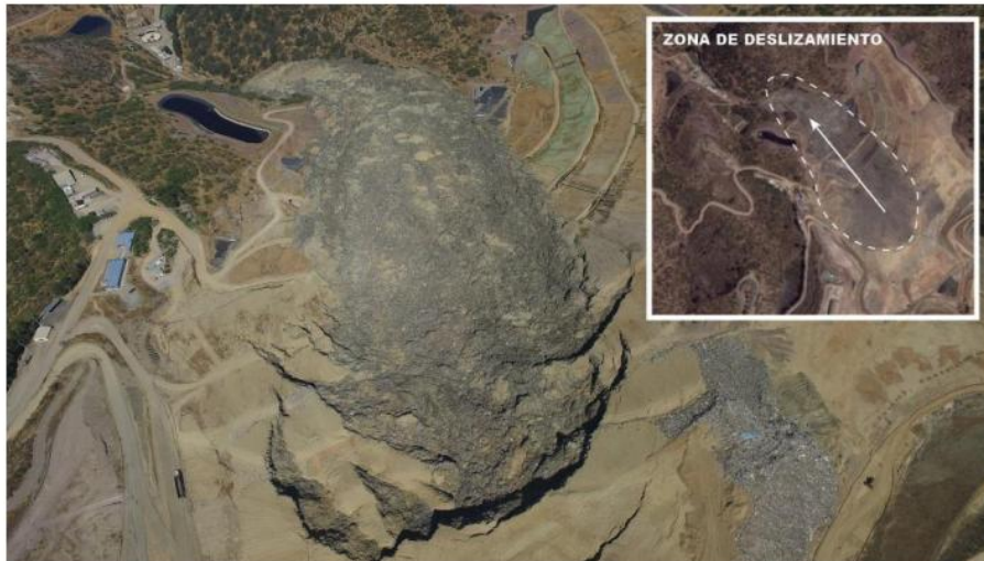
Figura N° 2: Rotura en relleno sanitario Santa Marta, Santiago de Chile – fotografía tomada de la publicación Altabella et al. (2016).
