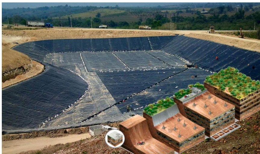
Figura Nº 6: Fotografía obras de inicio de un relleno sanitario. Extraída del diario La Región de Perú, fecha 4 abril de 2018.
