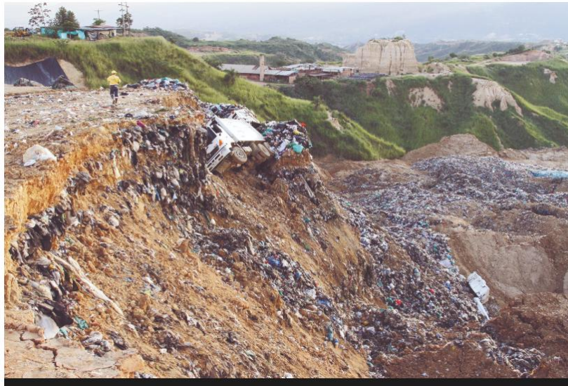
Figura N° 3: Rotura en relleno sanitario Bucaramanga, Santander, Colombia – fotografía tomada del diario El Espectador del 13 de octubre de 2018
