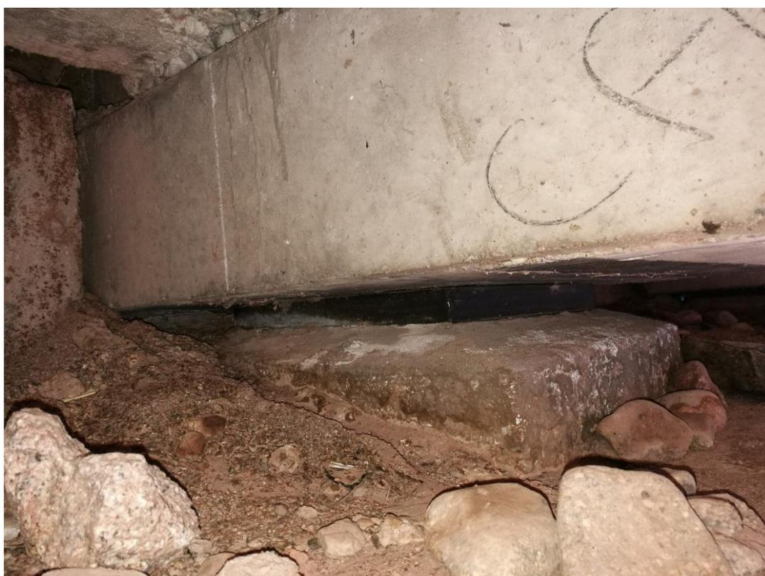
*Ilustración 14: Detalle Apoyo de neopreno y dado de hormigón.*
