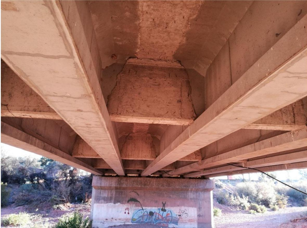
*Ilustración 11: Vigas longitudinales, vigas transversales y pila central.*
