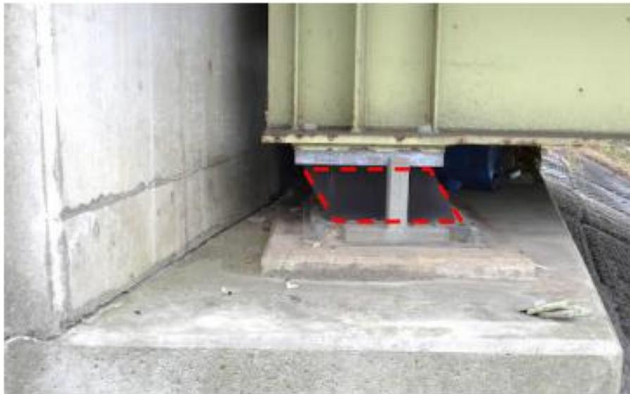
*Ilustración 94: Vista de deformación de apoyo de Neopreno.*
