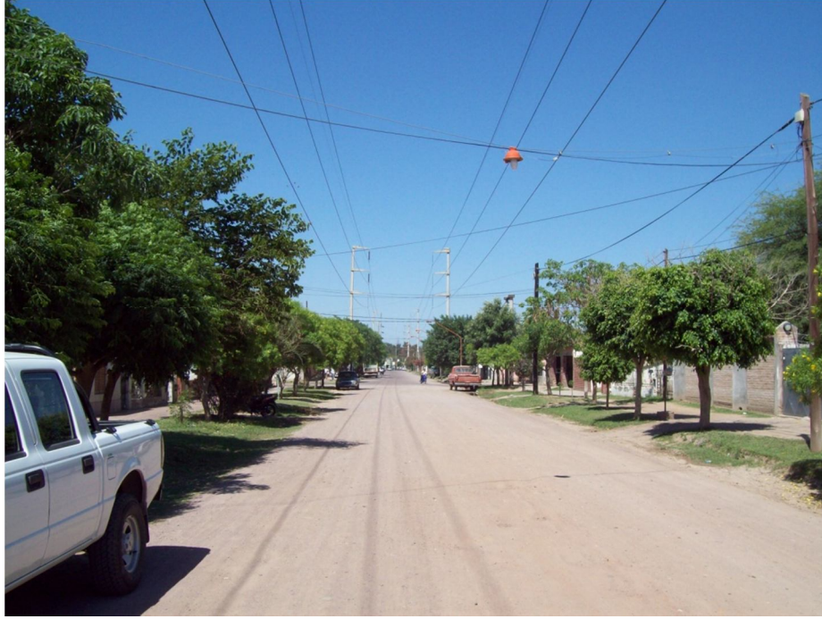
Fig. 13 LAT con distribución en bandera dentro de la Provincia de Santiago del Estero.
