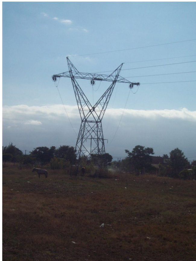
Fig. 14 Línea co-planar Provincia de Salta
