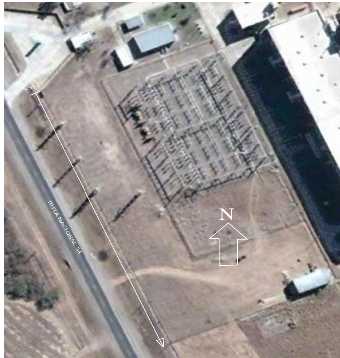
Fig. 20 Vista perimetral de la ET Güemes Fuente UNLP
