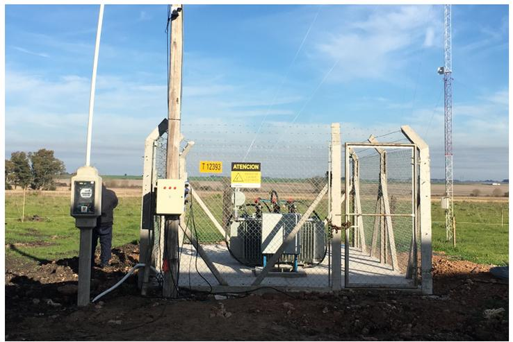
Posterior a sus seccionadores en aire tipo KERNEL, se canaliza subterráneamente hasta llegar a la máquina de transformación actual y de carácter provisorio de la industria. Se prevé una re-ubicación del PTMT hacia el lateral oeste del establecimiento, propiciando una vista más limpia de la industria.
