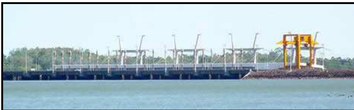
FIGURA II - 78 - Represa de Salto Grande. Fotografía tomada aguas arriba de la presa.
