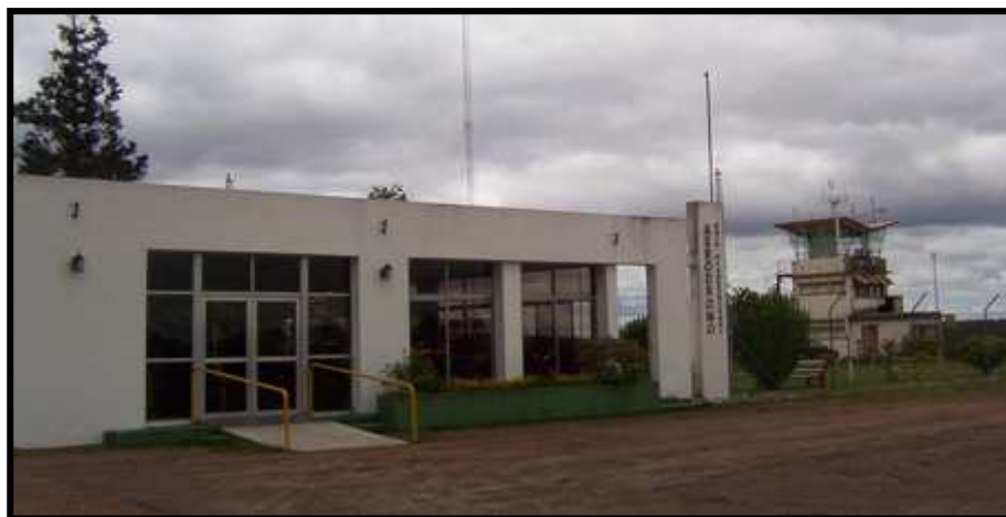
FIGURA II - 37 -Terminal del Aeropuerto “Comodoro Pierrestegui”.
