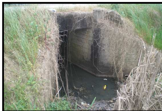
FIGURA III - 22 - Alcantarilla ubicada sobre Av. Monseñor Rosch.
