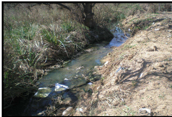
FIGURA III - 26 - Fotografía del Arroyo sobre Bv. Ayui Oeste.
