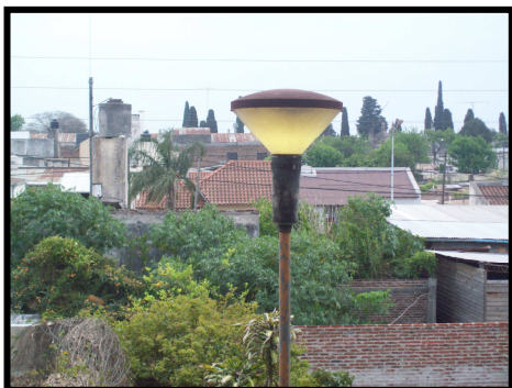
FIGURA II - 54 - Luminaria con cono invertido, provista con lámpara mezcladora de 160 [W], usada en espacios verdes.
