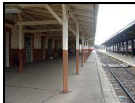
FIGURA II - 62 - Andén de la Estación Central Concordia.
