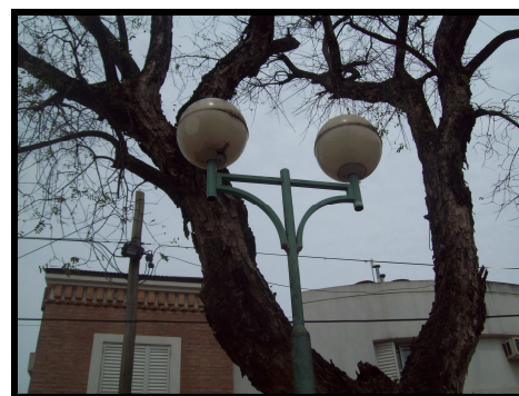
FIGURA II - 55 - Globo polietileno, con lámpara de sodio de alta presión, utilizado en plazas y espacios verdes.
