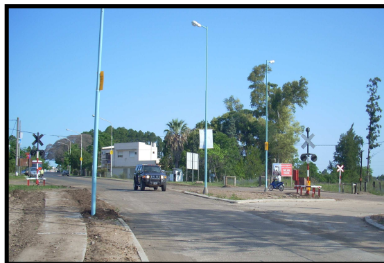
FIGURA III - 42 - Fotografía del paso a nivel en Av. Independencia.
