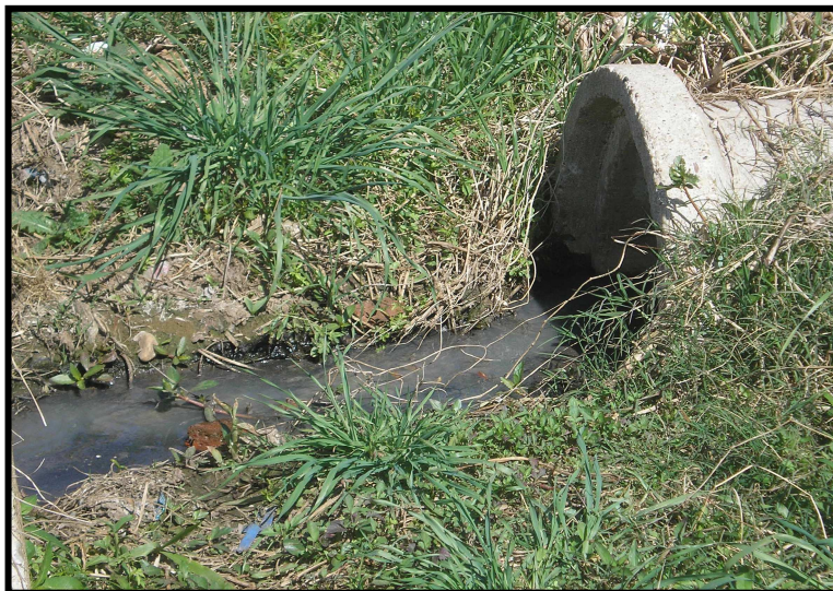
FIGURA III - 24 - Caño de descarga de efluentes cloacales al Arroyo.
