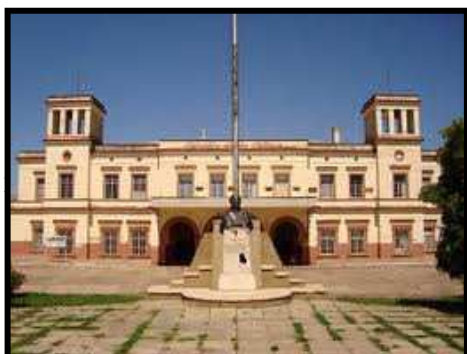
FIGURA II - 61 - Frente de la Estación Central Concordia sobre Av. Robinson.
