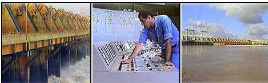
FIGURA II - 79 - Represa de Salto grande. Vertederos, sala de máquinas y fotografía tomada aguas abajo de la presa.
