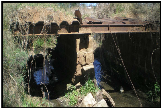
FIGURA III - 17 - Alcantarilla de dos bocas, ubicada sobre calle Las Palmeras.
