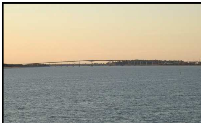
FIGURA II - 22 - Puente Internacional Gral. Artigas.
