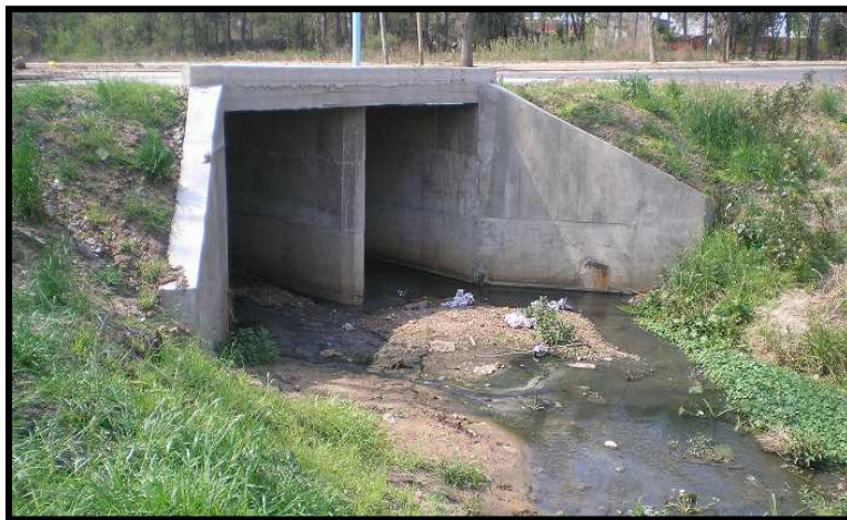
FIGURA III - 16 - Alcantarilla sobre Av. Independencia.
