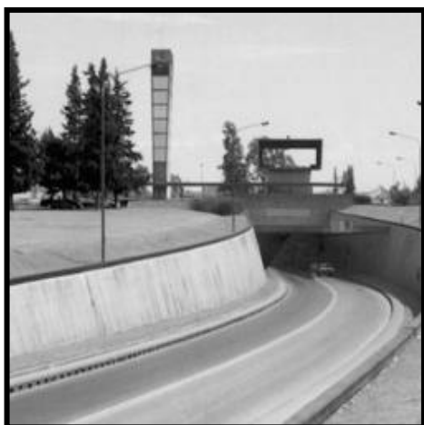
FIGURA II - 21 - Ingreso Túnel Subfluvial "Uranga - Sylvestre Begnis".
