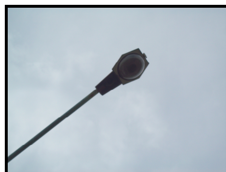
FIGURA II - 59 - Columna metálica tipo jirafa, provista de artefacto con lámpara de sodio de alta presión.
