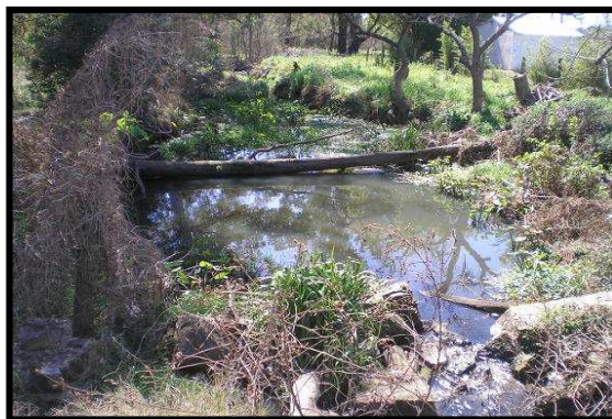
FIGURA III - 30 - Fotografía del Arroyo, aguas abajo de la alcantarilla ubicada en calle Las Palmeras.
