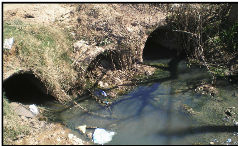
FIGURA III - 19 - Alcantarilla de tres caños ubicada, sobre Bv. Ayuí.
