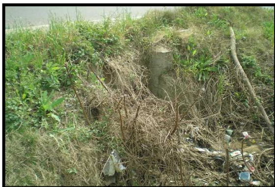
FIGURA III - 21 - Alcantarilla ubicada sobre Av. Monseñor Rosch.
