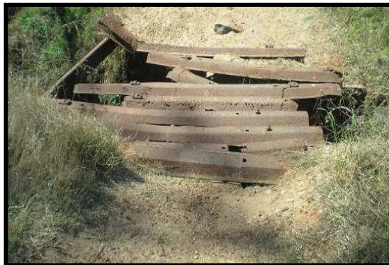
FIGURA III - 18 - Parte superior de la alcantarilla ubicada sobre calle Las Palmeras.
