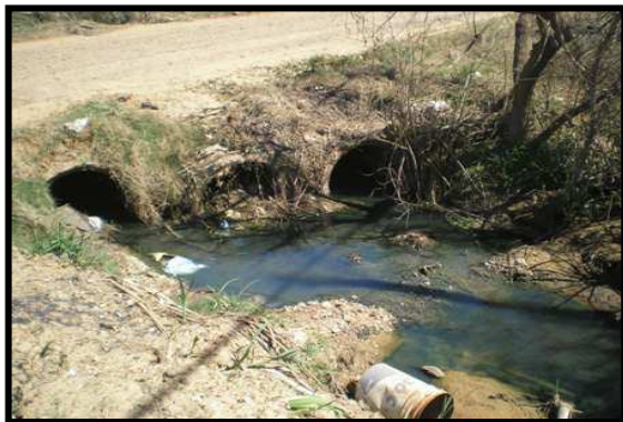
FIGURA III - 25 - Fotografía del Arroyo sobre Bv. Ayui Oeste.
