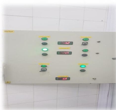
Central de Control de temperatura
