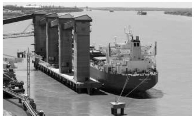
Fig. 4. Sector de embarque de grano acondicionado [11].
