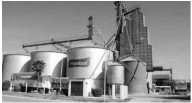
Fig. 2. Acondicionadora de granos: silos de acopio, norias y secadoras [10].
